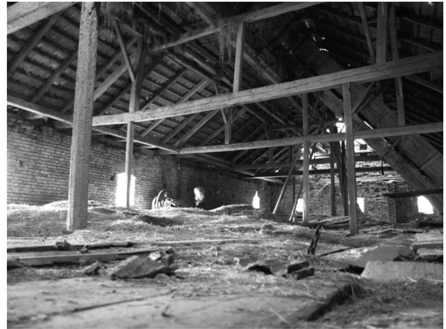
Abbildung 22: offener Dachstuhl mit Hängewerk im Heuboden
