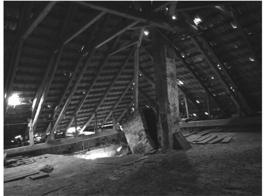
Abbildung 51: Dachstuhl mit eingestürzter Obergeschosdecke im Wohnhaus
