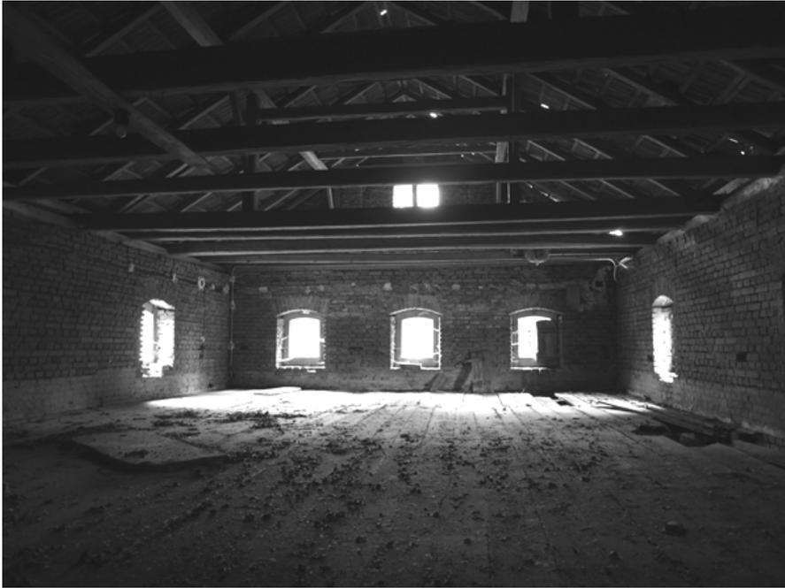
Abbildung 15: Dachstuhl des Droatbodens als zweifaches Hängewerk
