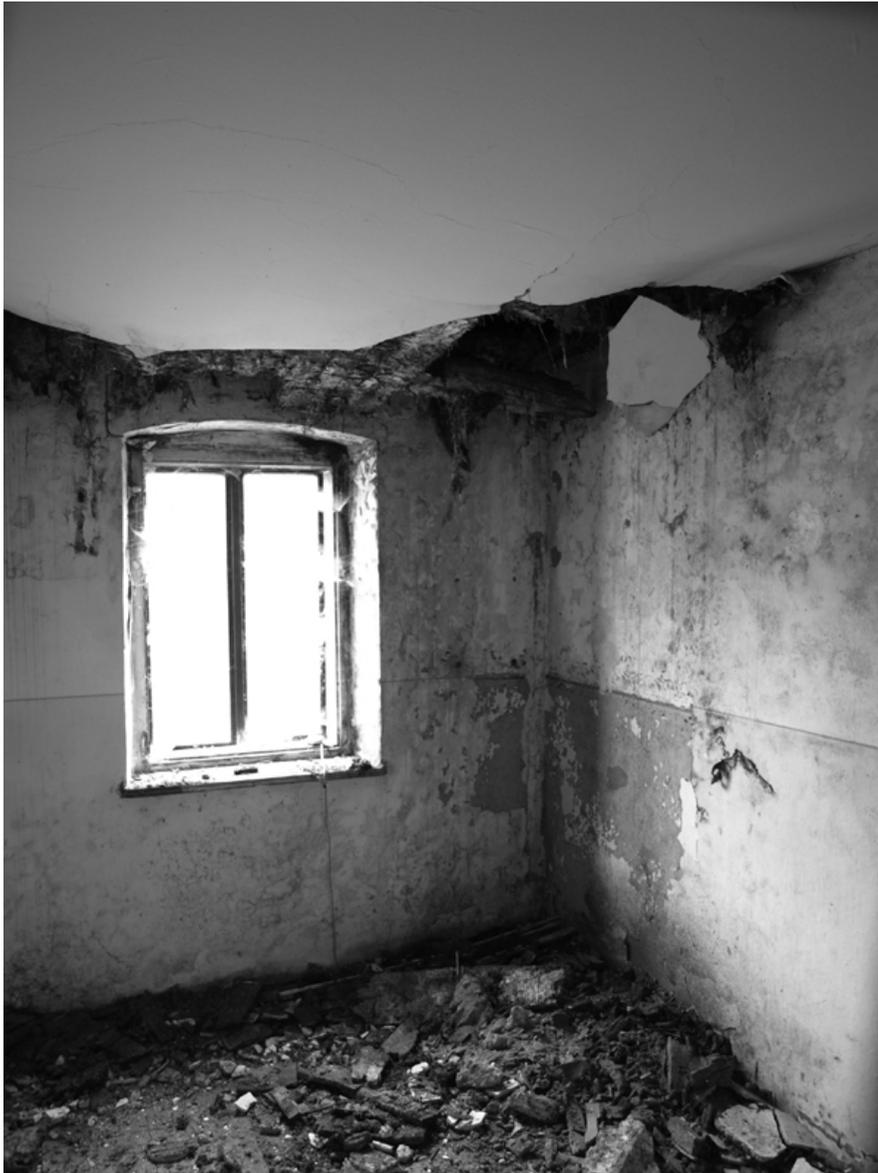
Abbildung 52: Labn, Deckeneinsturz im 1.OG
