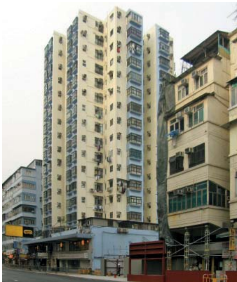
Abb. 5.16 Photo #4: Nachbargebäude, Ma Tau Wai Road
