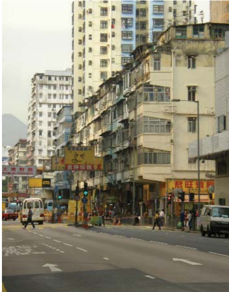
Abb. 5.14 Photo #2: Bestandsgedäude, Ma Tau Wai Road
