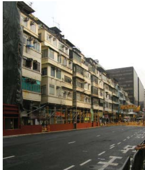
Abb. 5.17 Photo #5: Bestandsgedäude, Ma Tau Wai Road
