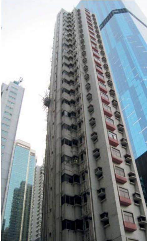
Abb. 4.14 Pencil Tower auf Hong Kong Island
