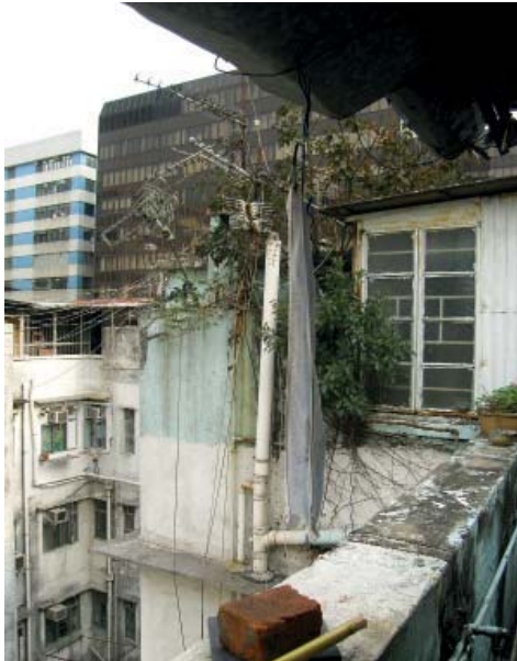
Abb. 5.22 Photo #10: Informelle Behausungen am Dach
