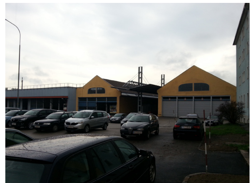
4- Planungsgebiet Blick von Gabelsbergerstraße Richtung Südosten
