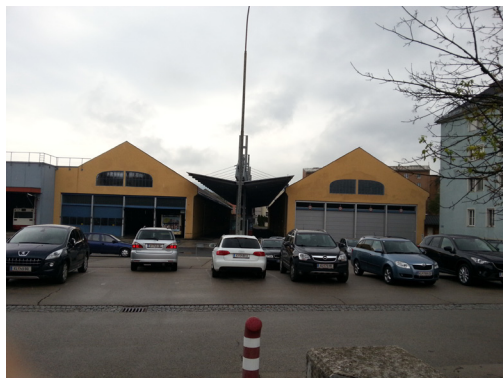
3- Planungsgebiet Blick von Gabelsbergerstraße Richtung Bahnhof
