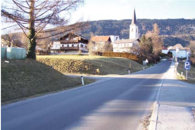
Blick auf die Zufahrt zum Bauplatz
