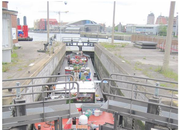
Eine Peniche in der Schleusenammer. Das Untertor schließt sich gerade. Der Haupttransportweg führt aber mittlerweile über den Haupthafen. Die Écluse de Mardyck ist der letzte Abschnitt des Großschiffahrtswegs Dunkerque-Escaut (Schelde), der für Frachtschiffe von bis zu 3000 Tonnen ausgebaut wurde. (siehe Grafik S.37)
