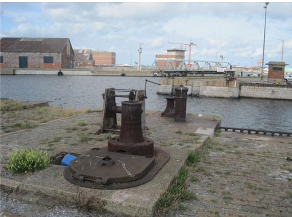
17. Das Trockendock wird mit einem sogenannten bateau-porte verschlossen. Im Hintergrund erkennt man die «Pont Môle 2». Sie ist die einzige Schwenkbrücke im Hafengebiet und verbindet die Môle 2 mit der Verlängerung der Citadelle. Eine Verbindungsbrücke von hier über den Einfahrtskanal ist über das Projekt Grand Large geplant.
