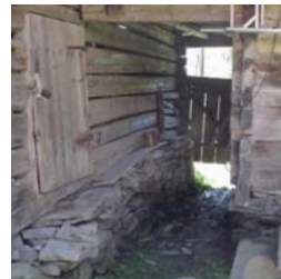
Sockelbereich unter dem Heustadl, unverputzt
