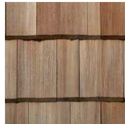
32 Dachdeckung Lärchenschindeln
