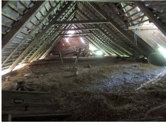
oben links: Aufgang Getreidestadt zum Futterboden oben rechts: Futter- boden über Kuh- u. Schweinestall unten links: Einstieg Futterboden unten rechts: Getreide- boden über Hühnerstall
