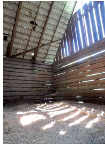
oben links: Durchfahrt mit darüberliegender Tenne oben rechts: Getreidestadt mitte links: Abstellraum/ Gerätelager mitte: Durchgang mitte rechts: Wagenschuppen unten links: Holzlager Ostansicht unten rechts: Schweinestall
