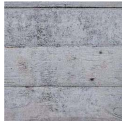
29 Sichtbeton mit Holzmaserung
