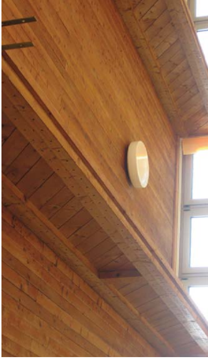
Abbildung 154 Fotographie 2010: Gruppenraum, Deckenkonstruktion
