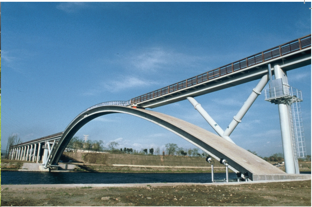
Oben: Brücke aus Textilbeton in Süd Korea. 1 Mitte: Wuzeltisch aus Textilbeton. Links: Texmodul am Campus der RWTH Aachen 2
