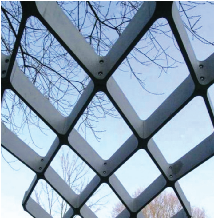
Oben und mitte: Rautentragwerk aus Textilbeton 1
