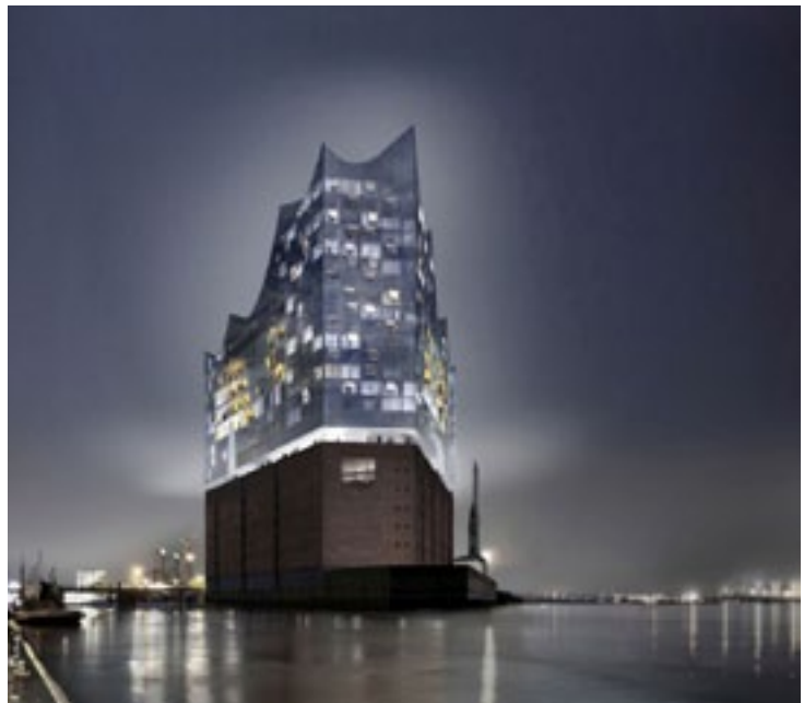
Elbphilharmonie Hamburg, von Herzog / de Meuron, in Bau
