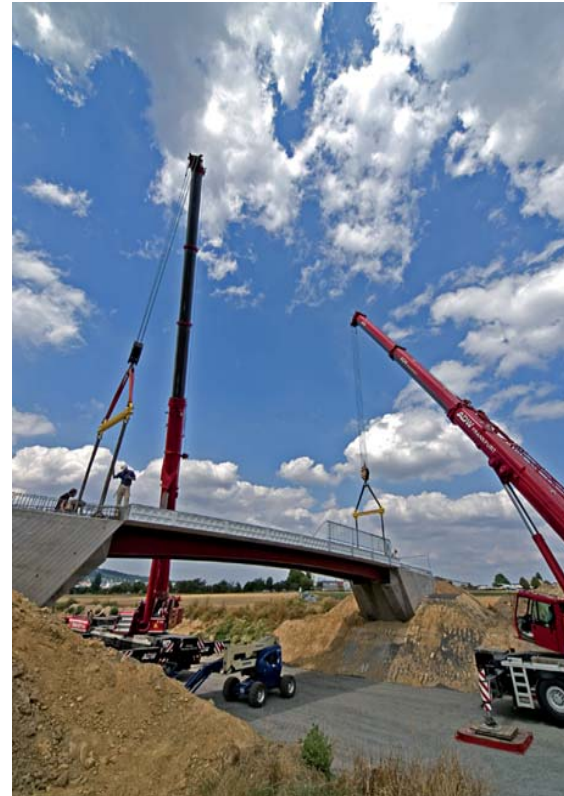
Abb. 4.2.8.2/2: Errichtung einer Brücke mit GFK als Tragstruktur
