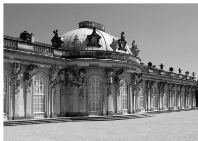
Abb. 6: Schloss Sanssouci. Blick auf die Südfassade. Potsdam/ Deutschland 1745-47
