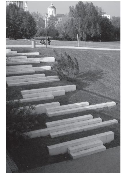
Abb. 15: Sitzstufen aus Beton mit Treppenfunktion
