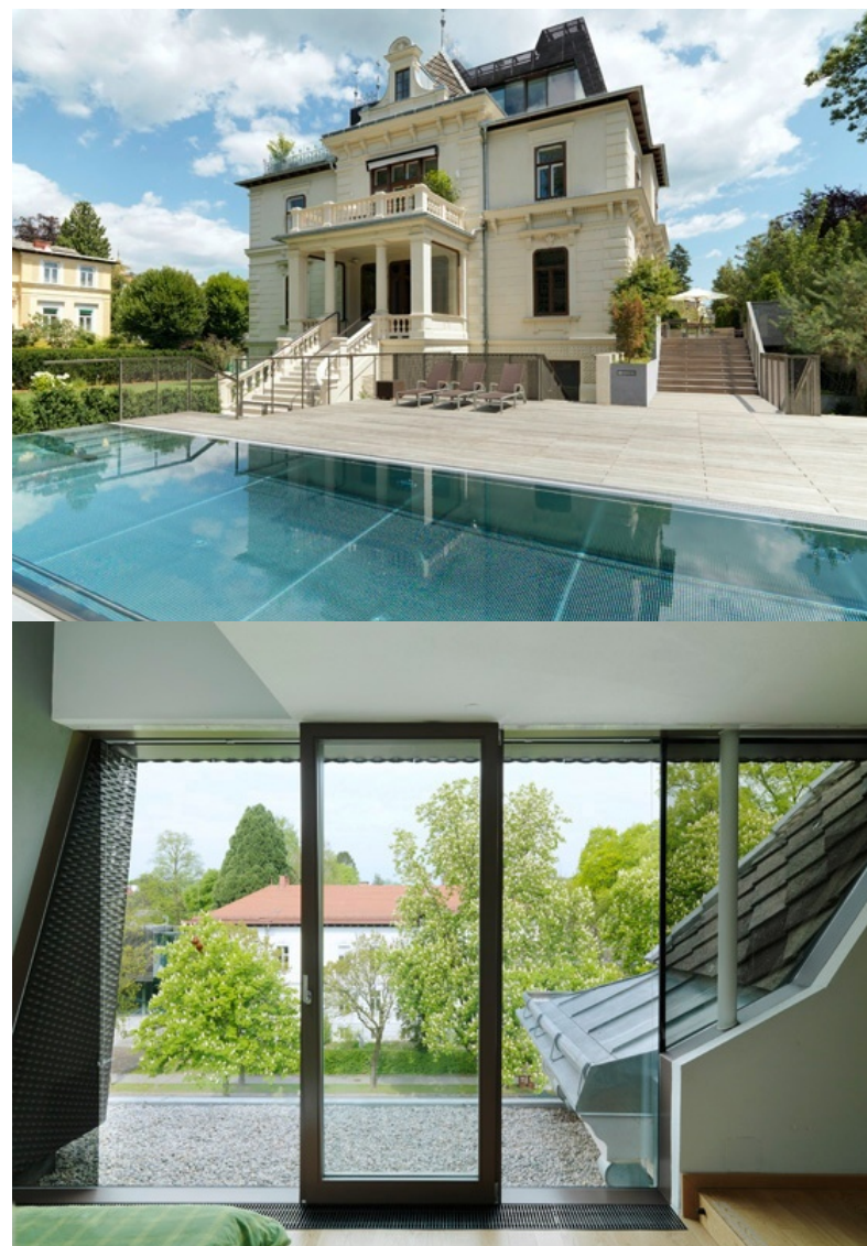
Abb. 71: Dachausbau, Villa in Graz – Gangoly & Kristiner Architekten ZT GmbH, Foto: Paul Ott
