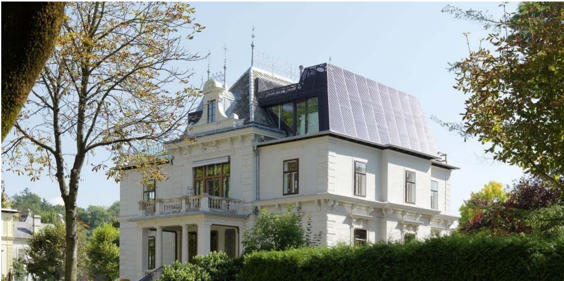
Abb. 70: Dachausbau, Villa in Graz – Gangoly & Kristiner Architekten ZT GmbH, Foto: Paul Ott
