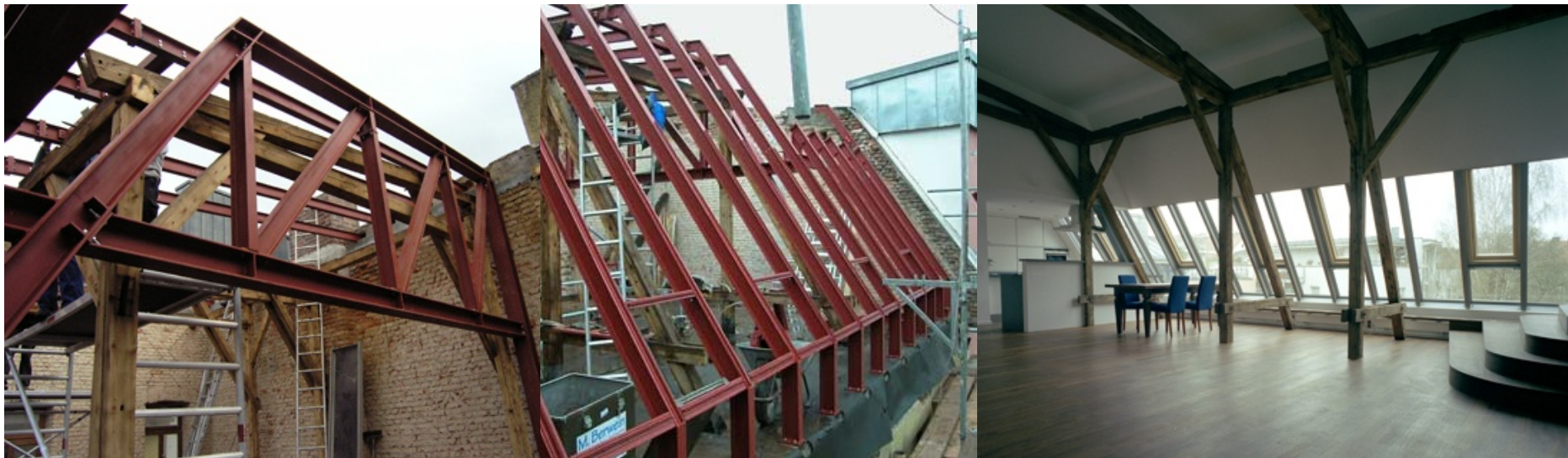
Abb. 74: Holzdachstuhl und neues Stahltragwerk – alte Bausubstanz erfordert individuelle Konzepte und Maßarbeit
