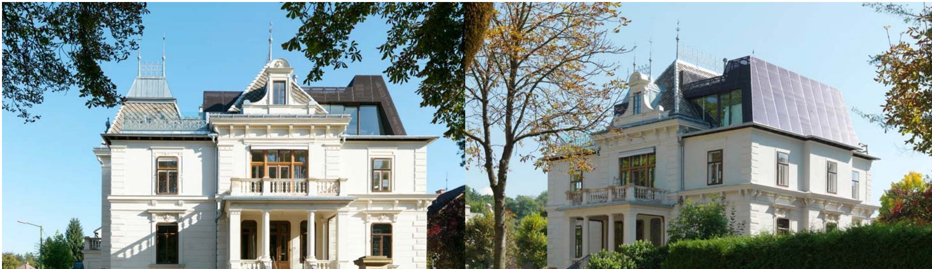
Abb. 72: Dachausbau, Villa in Graz – Gangoly & Kristiner Architekten ZT GmbH, Foto: Paul Ott
