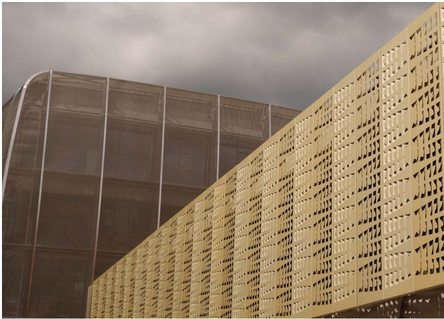
Abb. 151 Die in Bau befindliche Fassade
