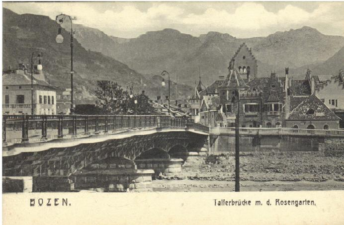
Die Talferbrücke ist aus Gusseisen und wurde 1899 von der Firma Waagner Birò in Graz geplant und hergestellt. Die Jugendstilbrücke ist über 130 Meter lang und ersetzte eine Holzbrücke aus dem frühen 19. Jhdt.
