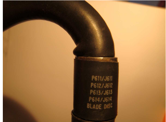
(b) Stauchung in der Ummantelung des Heckrotorkabels
