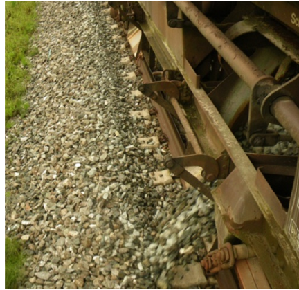
Abbildung 1-3: Nachschotterung - dosierte Entladung während der Fahrt 7
