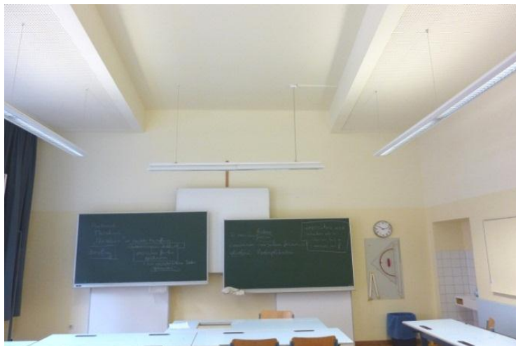
Abbildung 155: Akustische Sanierung mit Gipskartonlochplatten, Frontseite des Klassenzimmers
