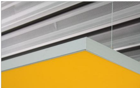
Abbildung 61: Farbiges Deckensegel aus Melaminharzschaum mit Alurahmen [SCHAUMSTOFFLAGER.DE]
