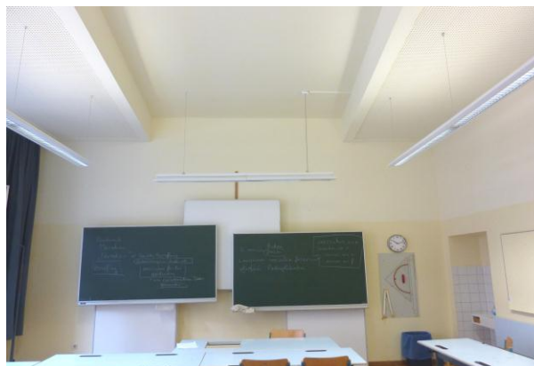
Abbildung 89: Akustische Sanierung mit Gipskartonlochplatten, Frontseite des Klassenzimmers
