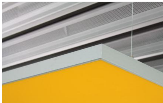
Abbildung 127: Farbiges Deckensegel aus Melaminharzschaum mit Alurahmen [SCHAUMSTOFFLAGER]
