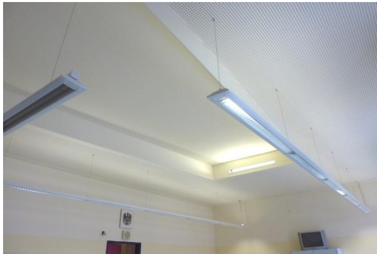
Abbildung 154: Akustische Sanierung mit Gipskartonlochplatten, Rückseite des Klassenzimmers
