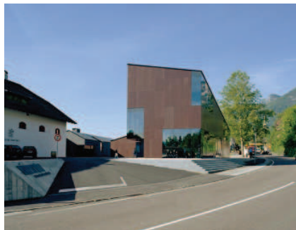
20 Ansicht Winecenter Kaltern
