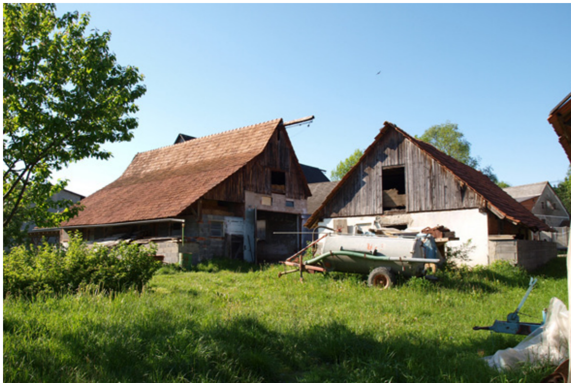
Abb. 82: Altes Wirtschaftsgebäude und alter Stall
