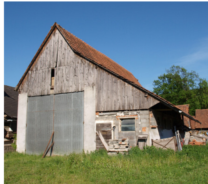
Abb. 83: Westansicht des alten Wirtschaftsgebäudes
