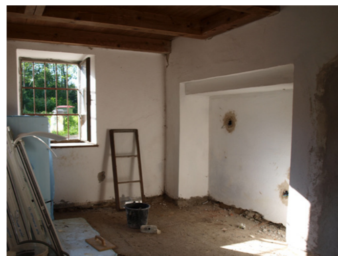
Abb. 25: Beginn der Sanierungsarbeiten
