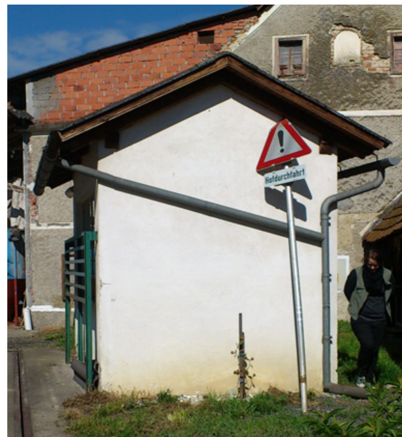
Abb. 44: Ansicht des Waagenhäuschens aus Osten
