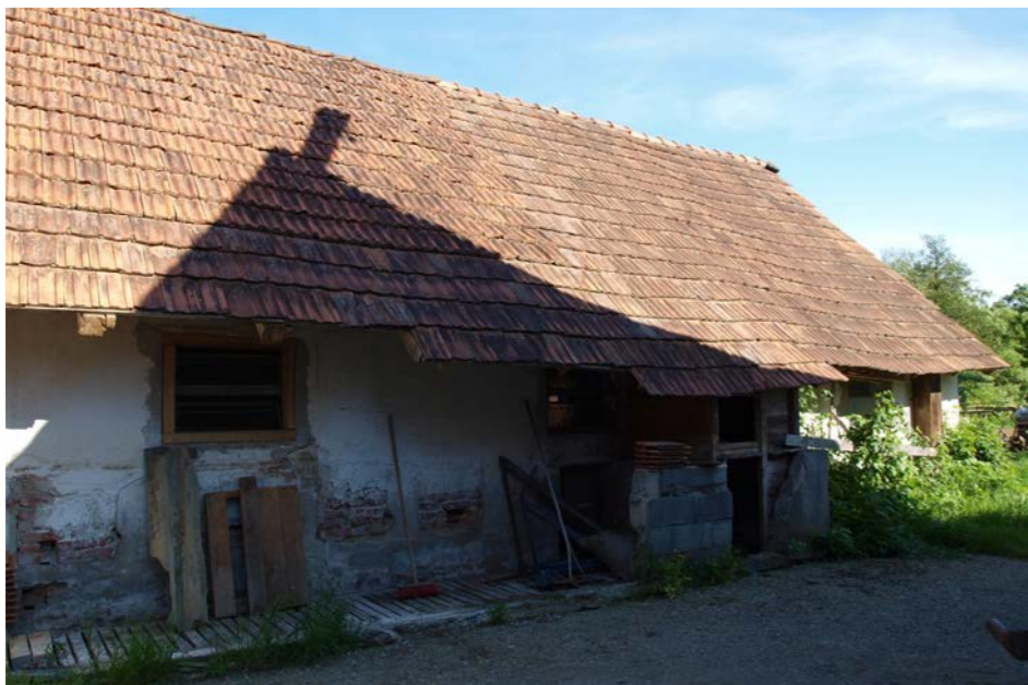
Abb. 76: Abbruch des Auslaufs der Schweine
