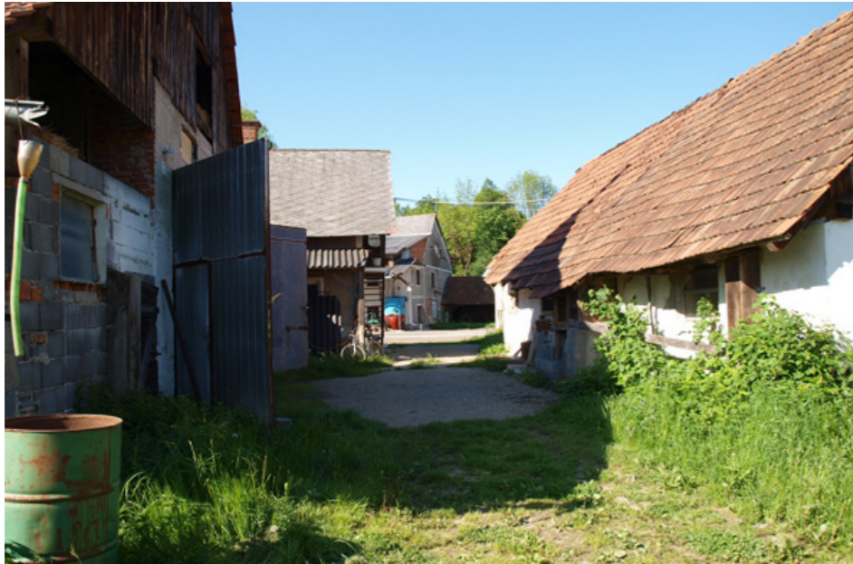
Abb. 75: Durchgang zwischen altem Wirtschaftsgebäude und altem Stall
