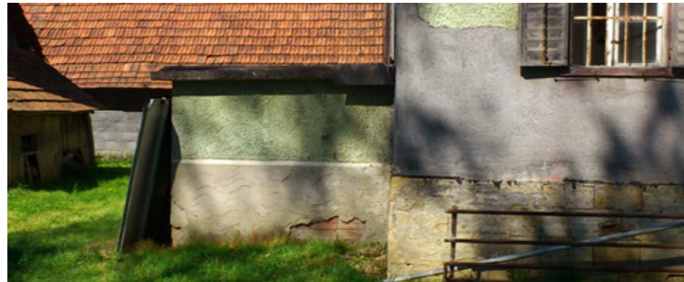
Abb. 55: Zugang zum Keller von außen
