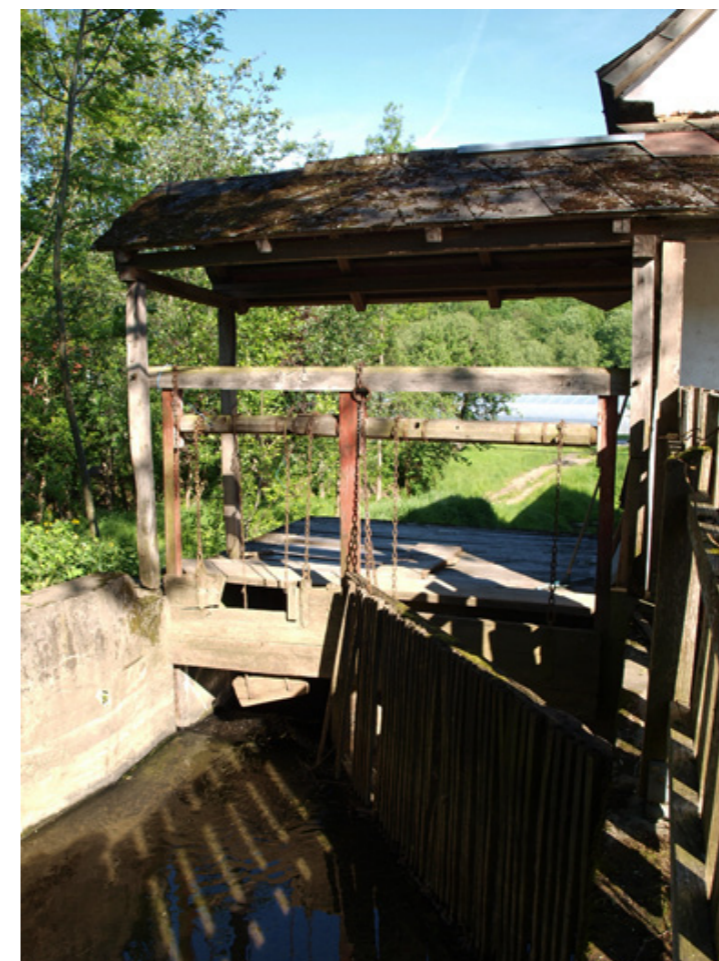
Abb. 34: Leer- und Einlaufschleuse
