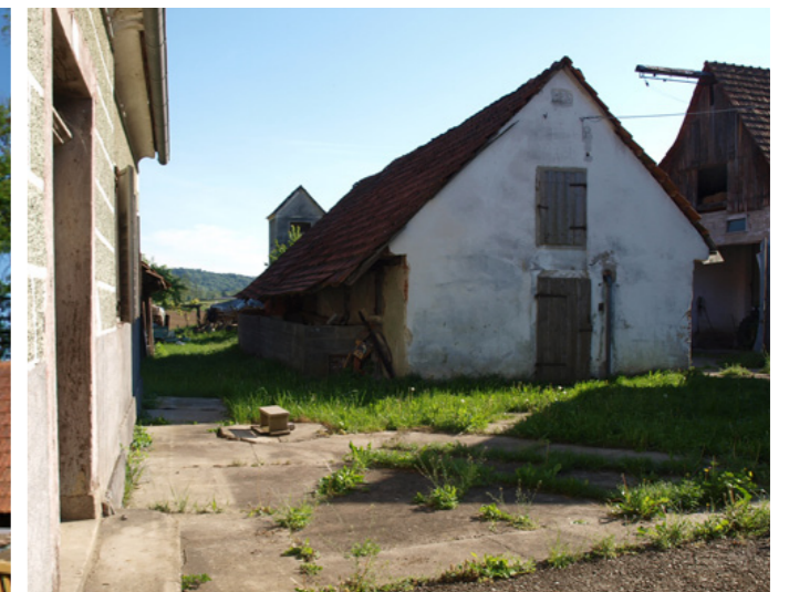
Abb. 79: Blick vom Wohnhaus auf den alten Stall
