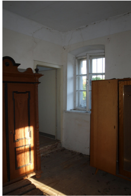
Abb. 59: Rissbildungen an der Decke Abb. 60: Innenwände aus Ziegel
