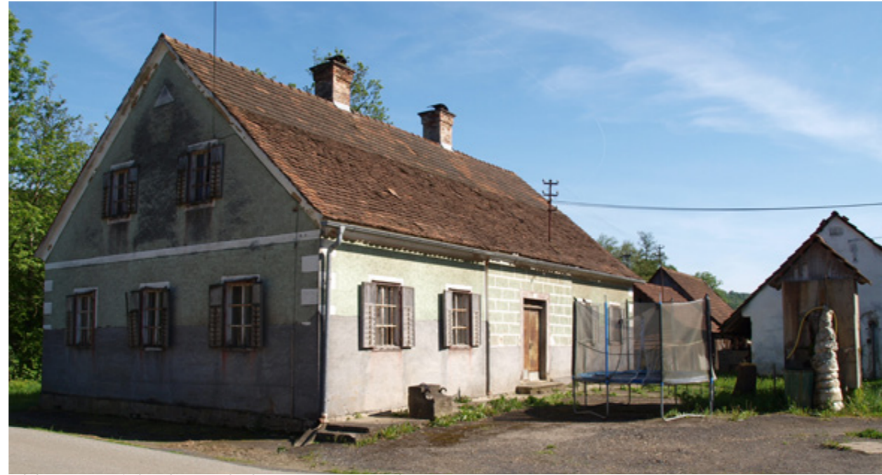
Abb. 46: Ansicht des Wohnhauses von Nordwesten
