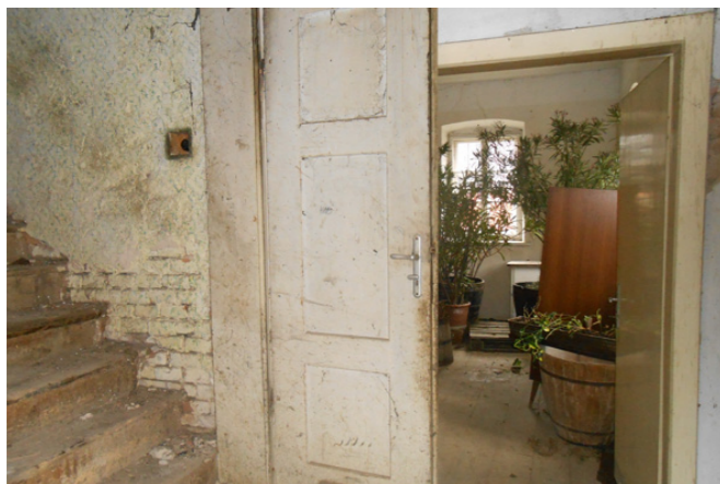
Abb. 62: Treppe in das Dachgeschoß
