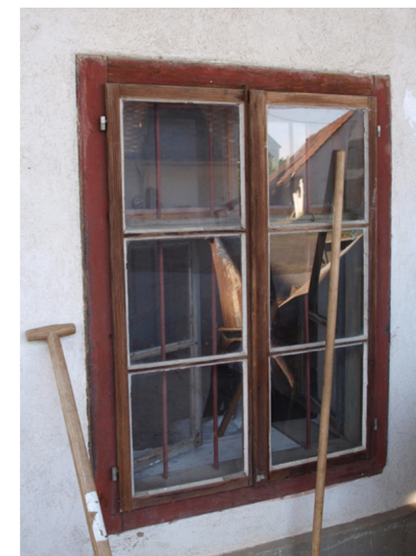
Abb. 27: Kastenfenster im Erdgeschoß
