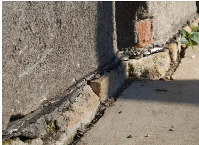
Abb. 61: Horizontalabdichtung
