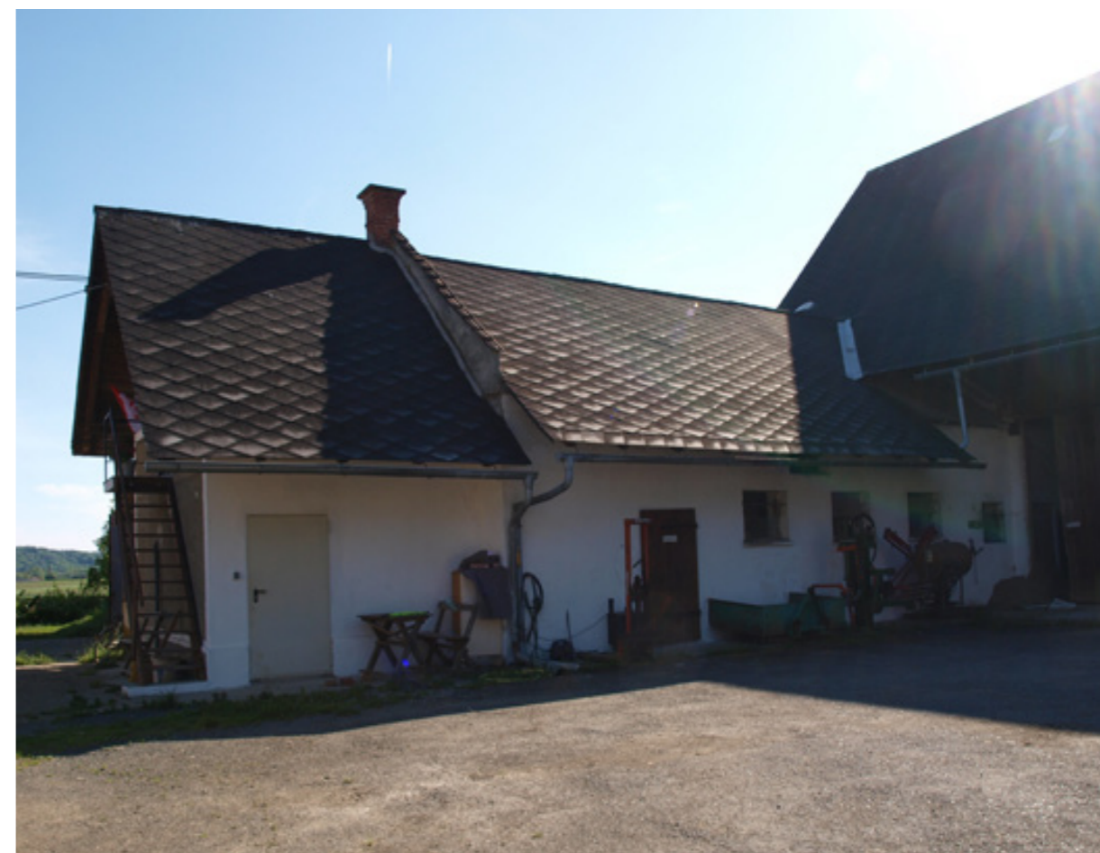
Abb. 70: Ansicht des Wirtschaftsgebäudes von Norden
