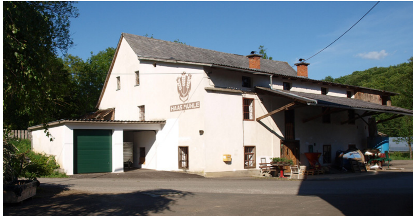
Abb. 13: Haas Mühle Ansicht West
