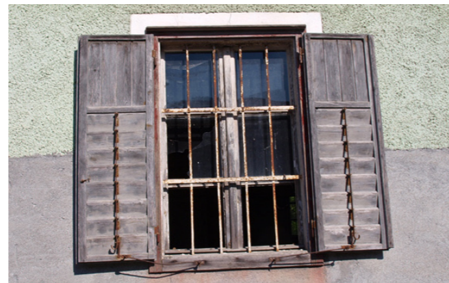
Abb. 50: Kastenfenster des Wohnhauses
