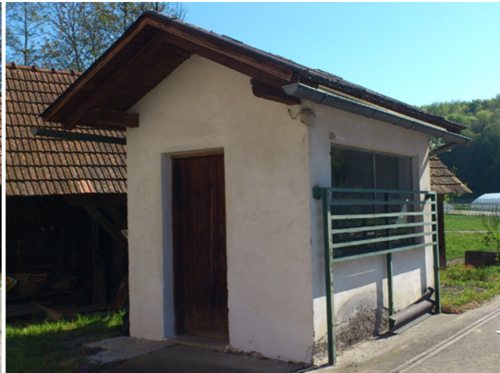
Abb. 42: Ansicht des Waagenhäuschens aus Westen
