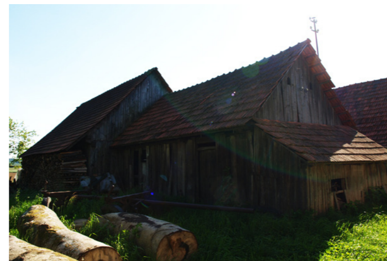
Abb. 74: Nordostansicht der Holzhütte
