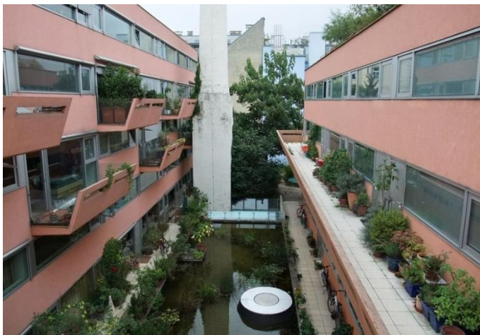
Abb. 26 Laubengangerschließung zum Innenhof orientiert
