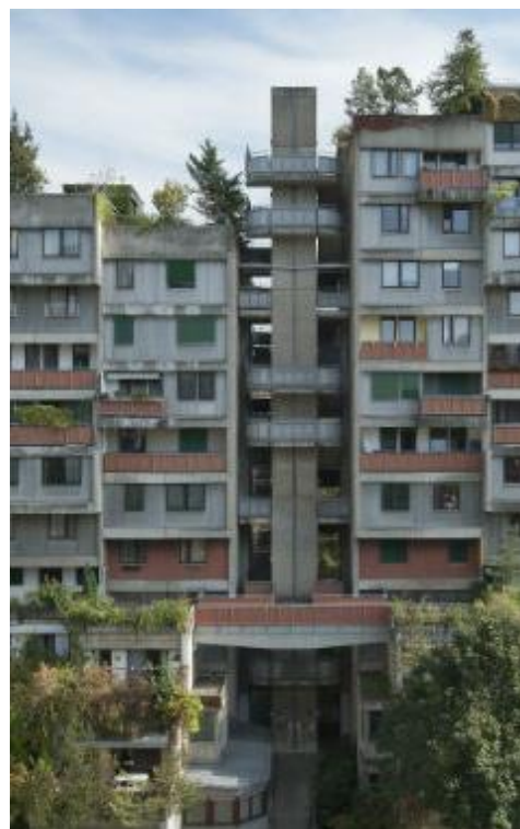
Abb. 11 offene vertikale Erschließung
