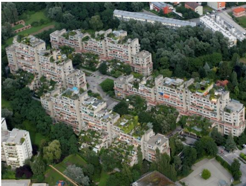
Abb. 10 Schrägluftbild der Anlage
