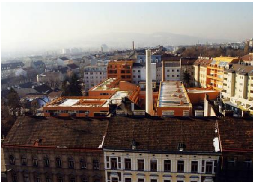
Abb. 21 Blick über die Dächer des Blocks
