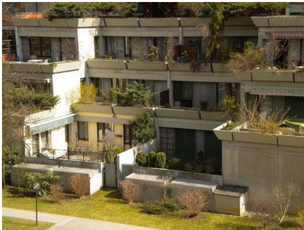
Abb. 16 terrassenartiger Aufbau der untereren Geschoße
