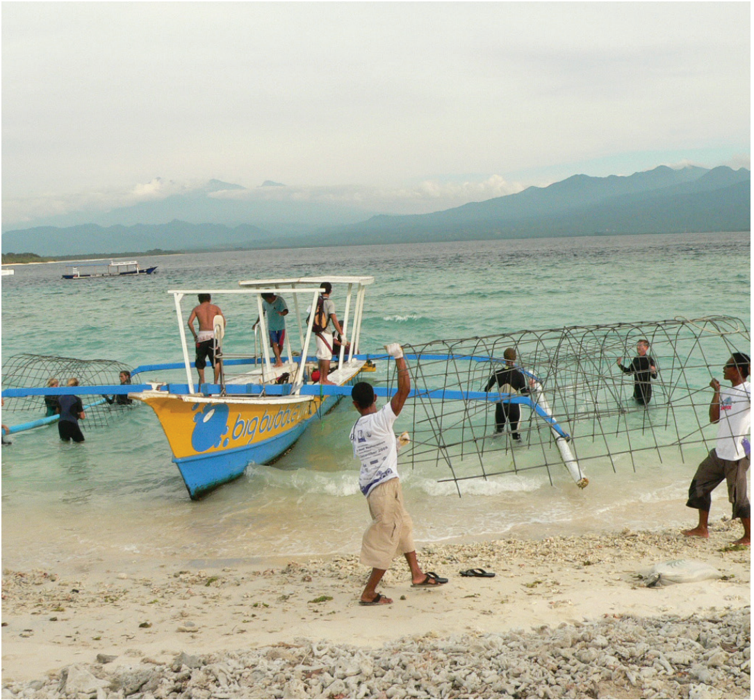
ABB. 44 Das Metalgerüst wird versenkt und durch ein nidriges Strom aktiviert
