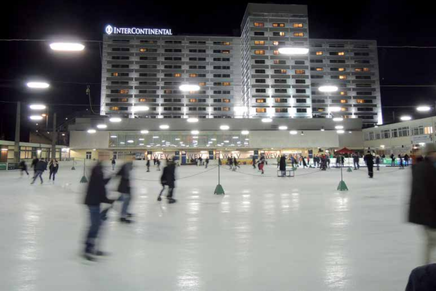
Abb. 54: Die Südfassade vom Eislaufverein aus gesehen.
