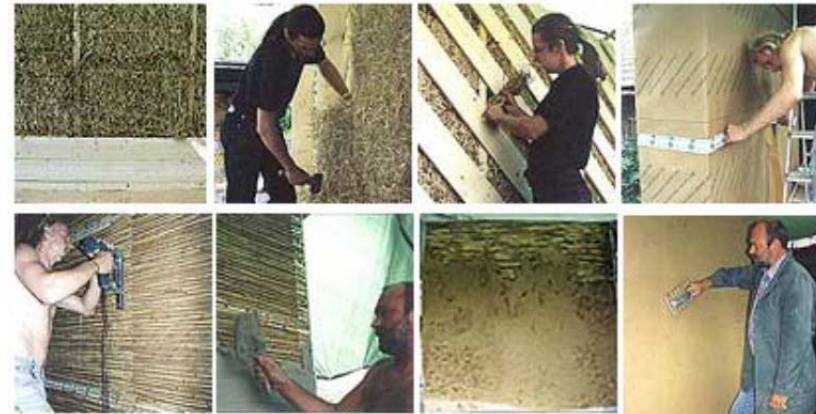
Errichtung der Probewand
