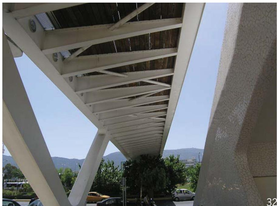
die auftretenden Seilkräfte ab und finalisiert damit die Tragstruktur. Wie bei Calatravas Entwürfen üblich sind alle Teile weiß gefärbt, die Gehfläche wurde mit einem Holzbelag versehen, der am Rand durch ein Stahlgitter begrenzt wurde. Unter diesem ist auch die Beleuchtung der
