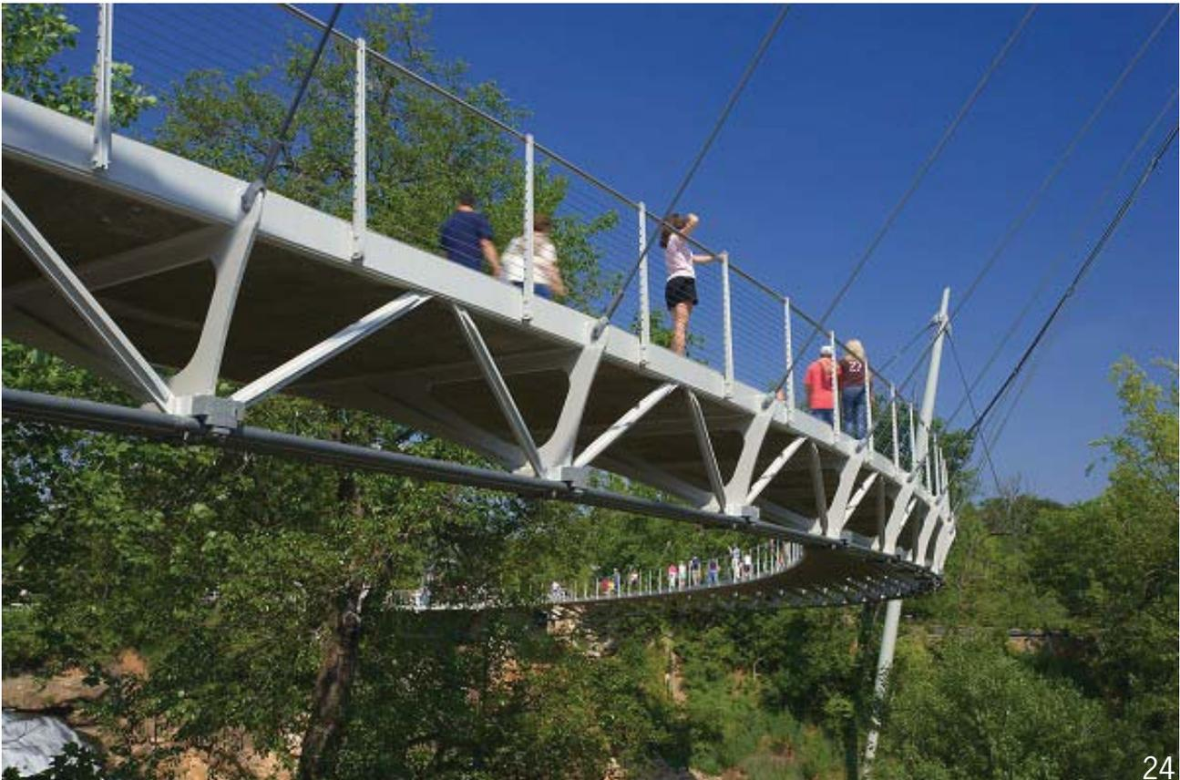
Das Tragsystem wird erst durch das Kabel unterhalb der Brücke vollständig. Es wurde an den zwei Widerlagern der Brücke fixiert (siehe Abb.26) und an den Stahlrahmen befestigt (siehe Abb.24). Es nimmt Torsionskräfte, als auch Dynamische Einwirkungen auf und hält
