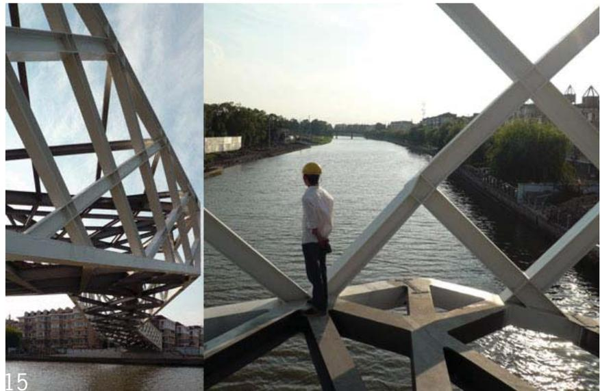
Die Ansicht der Brücke ist das Resultat der diagrammatischen Darstellung des auftretenden asymmetrischen Biegemoments und wurde direkt in der Konstruktion umgesetzt. Um die verschiedenen unterschiedlichen Konstruktionssegmente zu minimieren wurde ein Muster entworfen, dass mehr dem Diagramm der Schubbeanspruchung entsprach.
