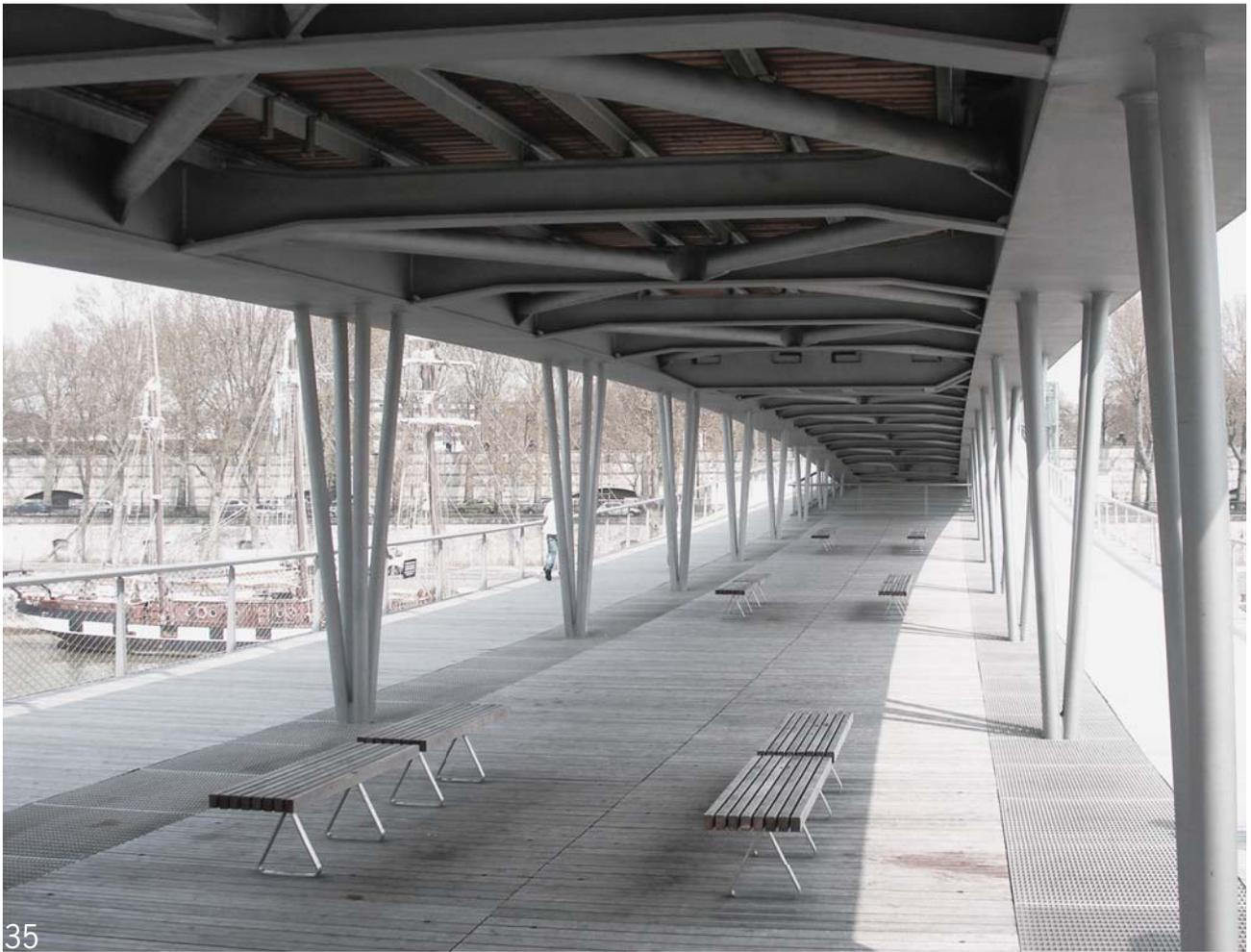
Sekundärkonstruktion gehalten und bildet die Deckfläche des Tragwerks. Daraus entstehen erhebliche Torsionskräfte, die über die Fläche des Mittelteils und schließlich über die klammerförmigen Auflager abgeleitet werden müssen.
