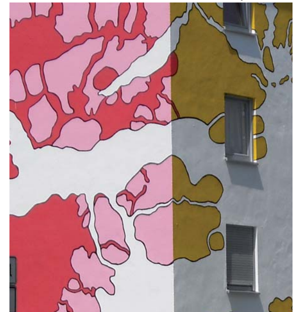
C. Kruse, Wohngebäude in Regensburg
