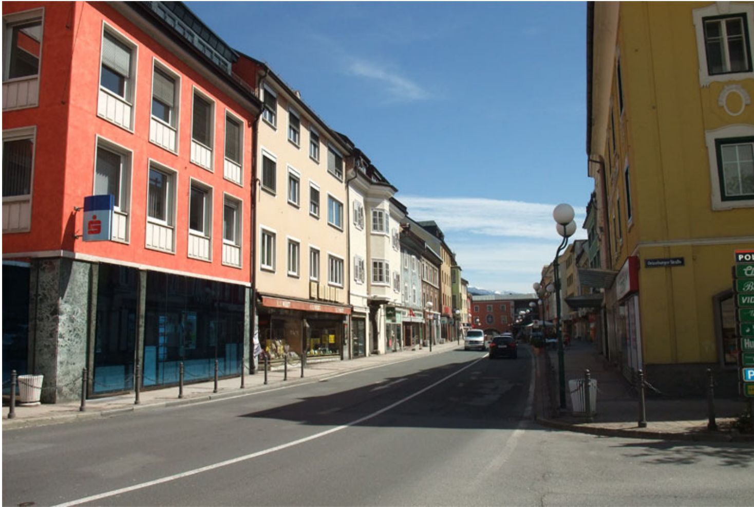
Abb.04: Hauptplatz, Blickrichtung Osten. 164
