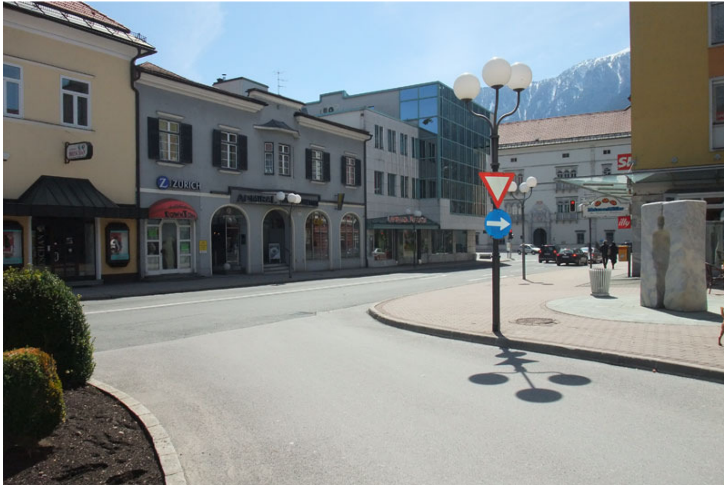
Abb.29: Neuer Platz, Blickrichtung Süden zum Burgplatz. 190
