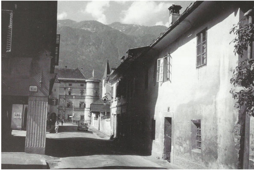
Abb.35: Die alte Nordeinfahrt führte durch enge Gassen und konnte dem steigenden Verkehrsaufkommen nicht mehr gerecht werden. 73
