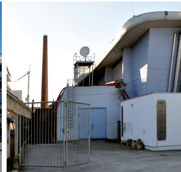
Nord- Westansicht Liebenauer Eishalle
