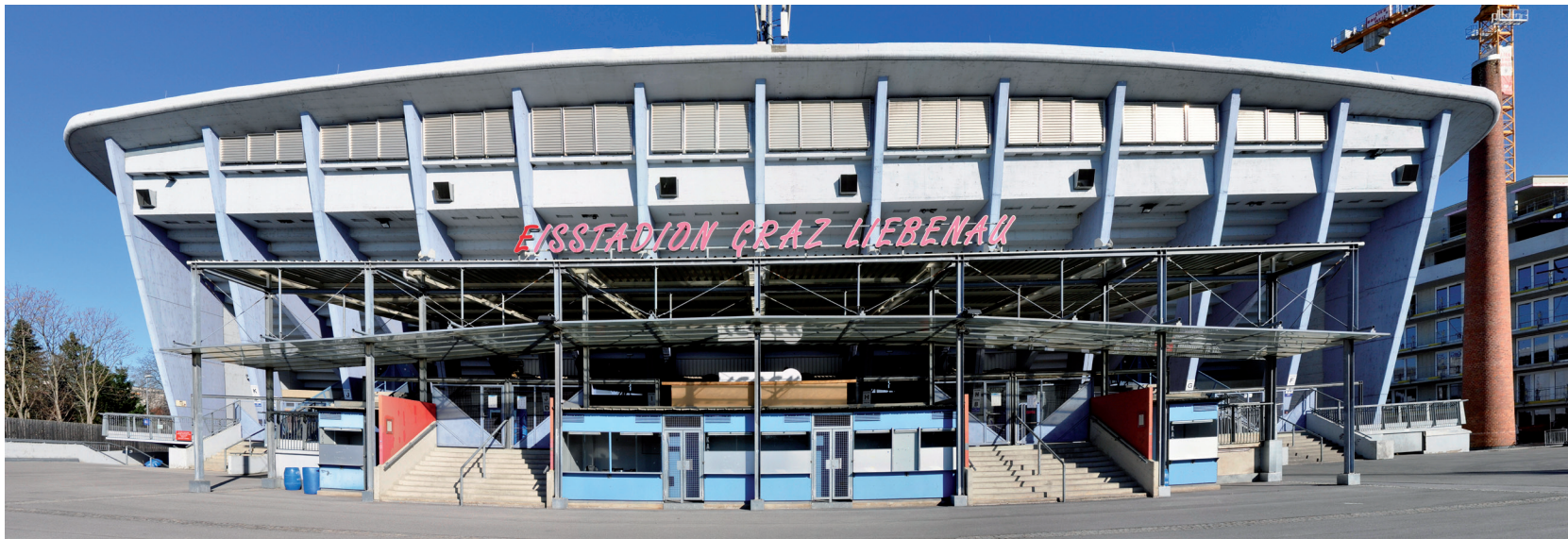
Südansicht Liebenauer Eishalle
