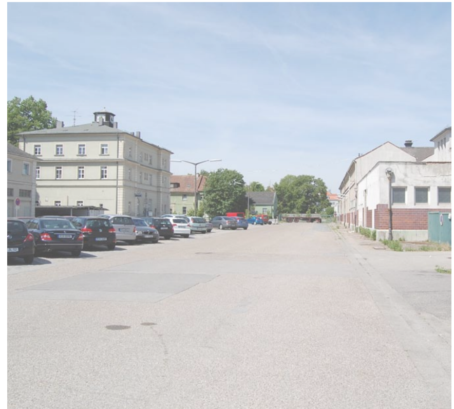
Abb.72: Nebengebäude im Süden
