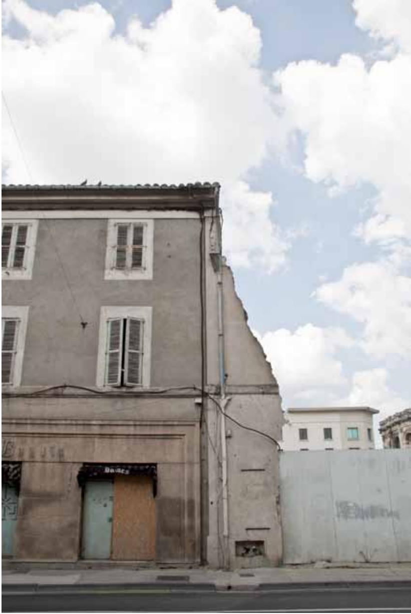
Îlot Grill, an der Rue de la République
