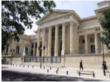
1 Le Palais de Justice an der Esplanade Feuchères
