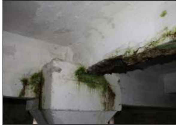
Abb. 62 beschädigter Träger
