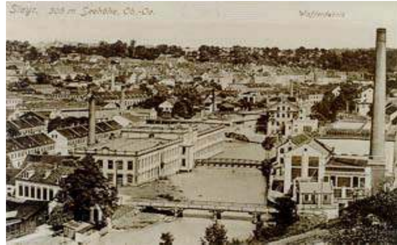
Abb.7 Hack Werke - Wehrgraben
