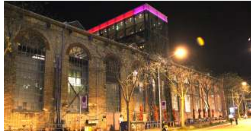
Abb. 82 Schiffbau Zürich von außen mit Skybar
