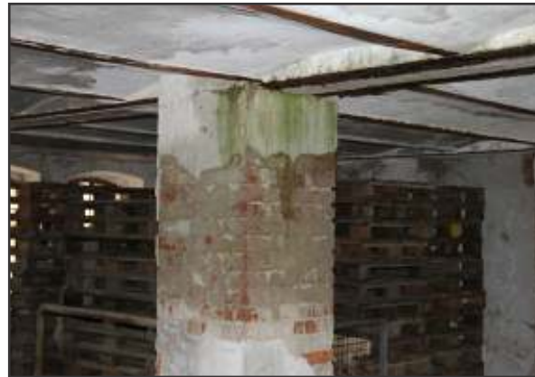
Abb. 50 Stütze mit Algen
