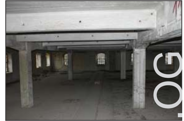
Abb. 63 hinterer Bereich Westtrakt
