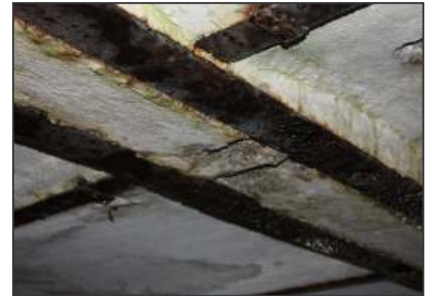
Abb. 51 angerosteter Träger
