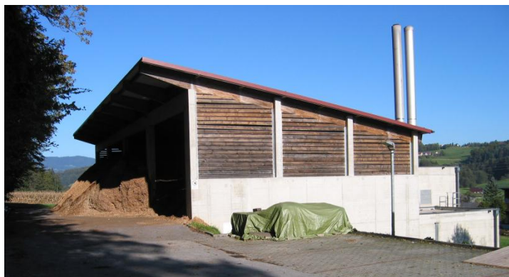
Abb. 1: Biowärme Heizwerk in Eggersdorf bei Graz
