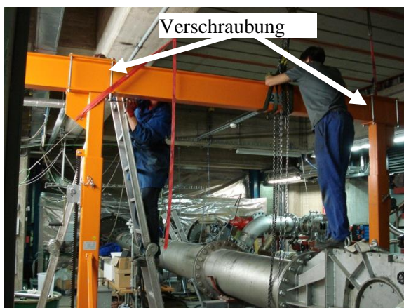
Abbildung 4-12: Verschraubung der Vertikalträger
