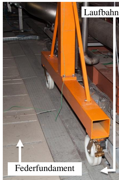
Abbildung 4-11: Stahlträger als Laufbahn des Krans
