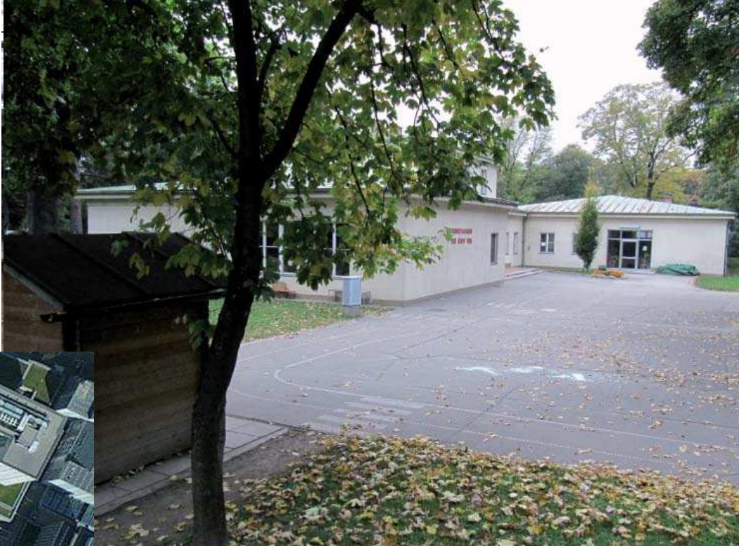
Blick von der stark befahrenen Straße Am Heumarkt aus
