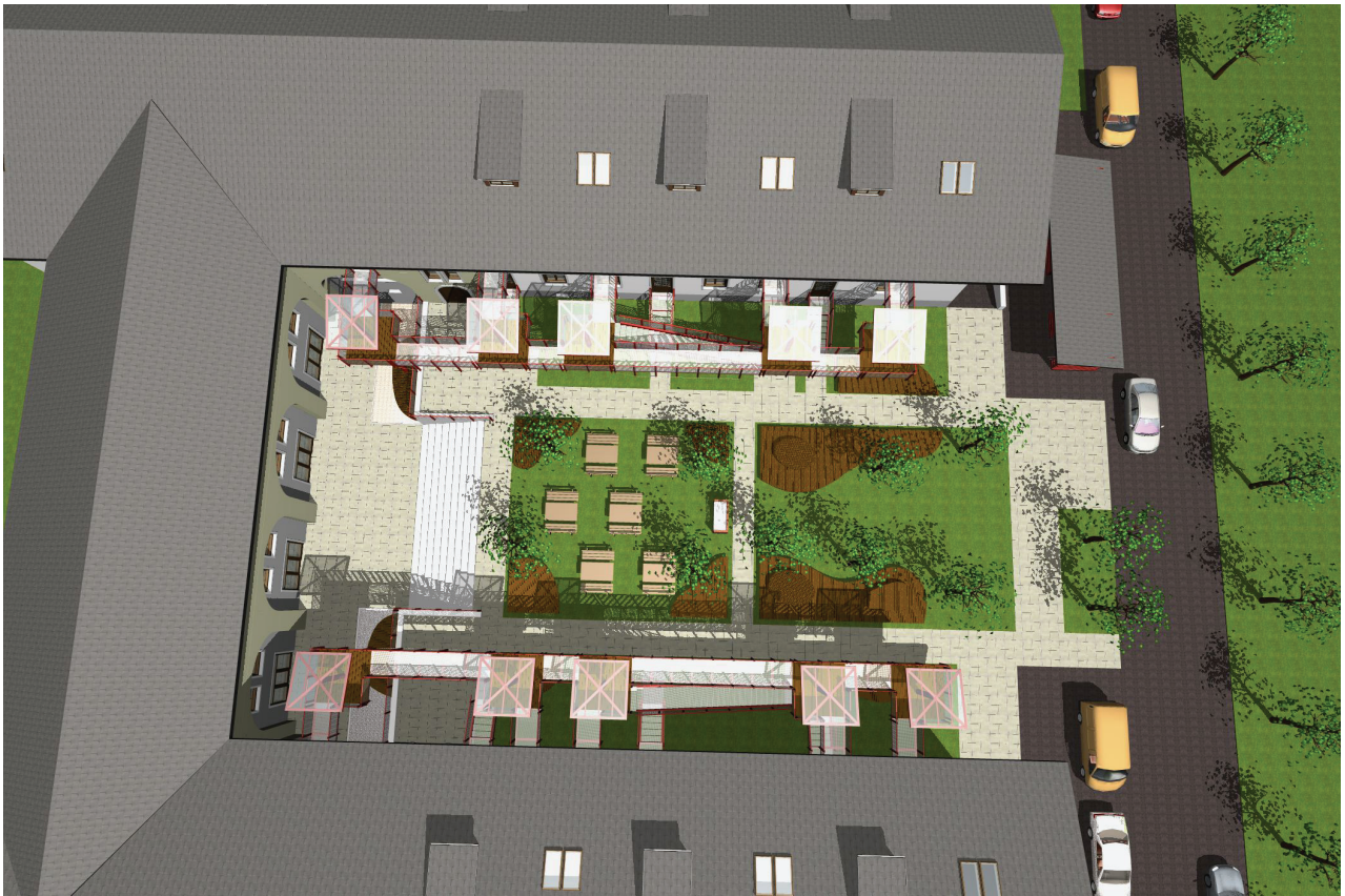
Dachdraufsicht mit neuen Dachflächenfenstern
