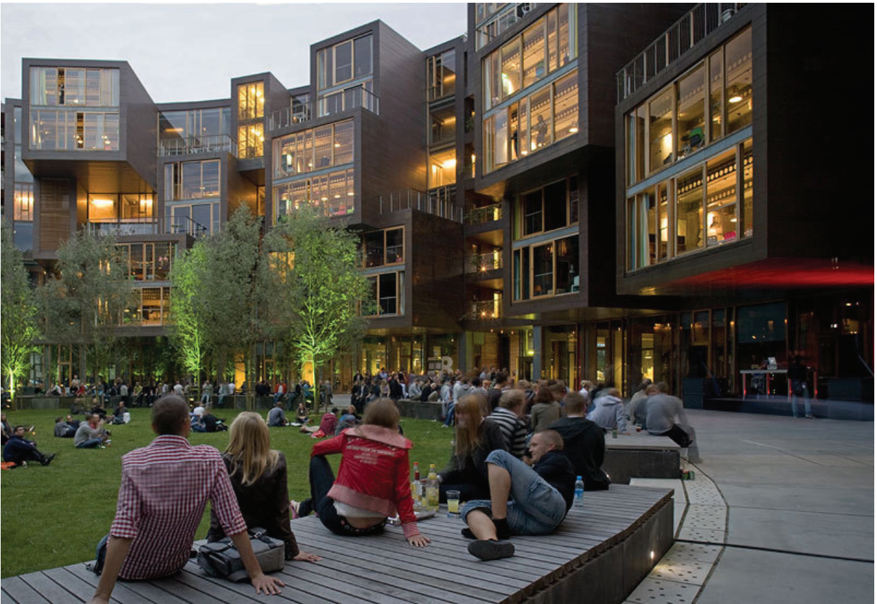
Abbildung 57: Der Innenhof als belebter Kommunikationsraum
