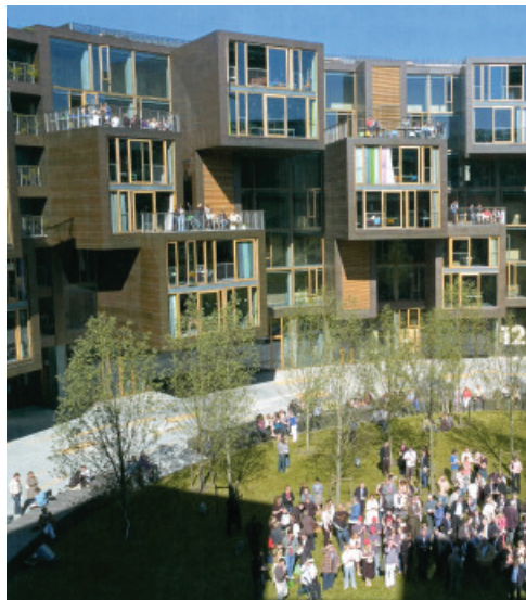
Abbildung 59: Die Gemeinschaftsräume sind ebenfalls zum Innenhof ausgerichtet
