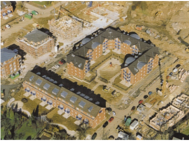
Abbildung 11: Umbau der Bestandsgebäude
