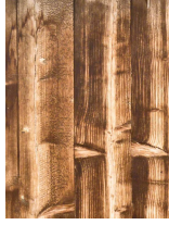
Fassade Lärche Vollholzfassade
