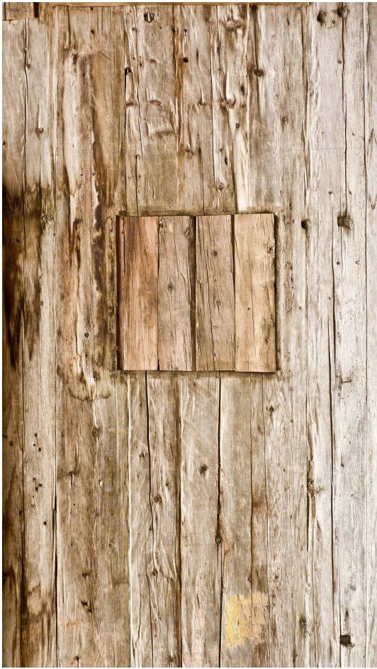
[ Standort: Pfedders Dorf- Blick Detail Blockbau Holz, alte Dorfstruktur; 07.04.2012; Barthien David]
