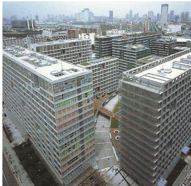
Abb.110 Eingangssituation der Wohnanlage
