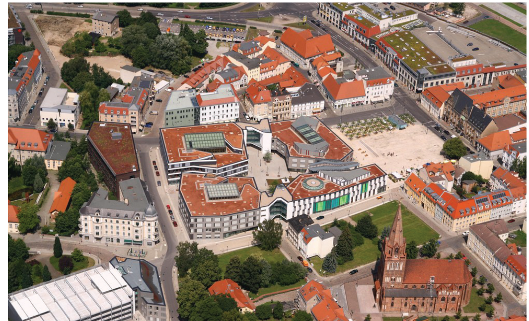
Abb. 128 Luftbild des Gebäudekomplexes
