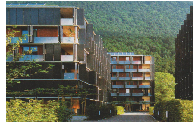
Abb.60 Punkthäuser in Innsbruck, Bauschlager & Eberle 2000
