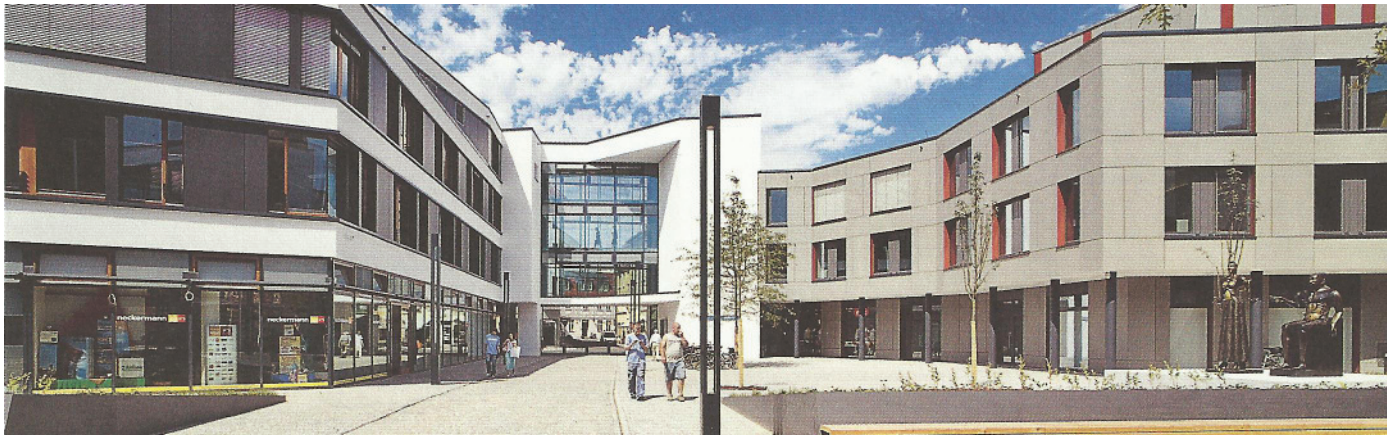
Abb. 132 Ansicht Torhaus Nord aus dem Innenhof
