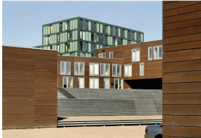
Abb.123 Ansicht in den Innenhof
