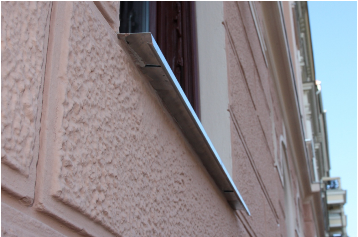
Abbildung 100: Metall-Außenfensterbank inklusive Sicherung gegen Abheben durch Wind
