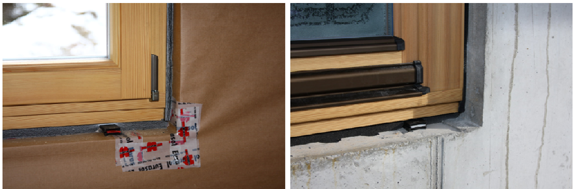
Abbildung 93: Anwendungsbeispiel von imprägnierten Dichtbändern
