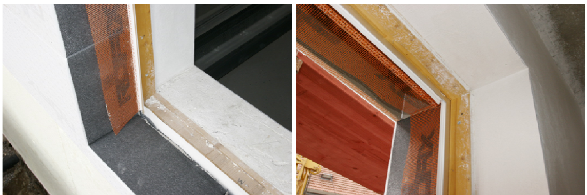
Abbildung 8: Anwendungsbeispiel Blindstock
