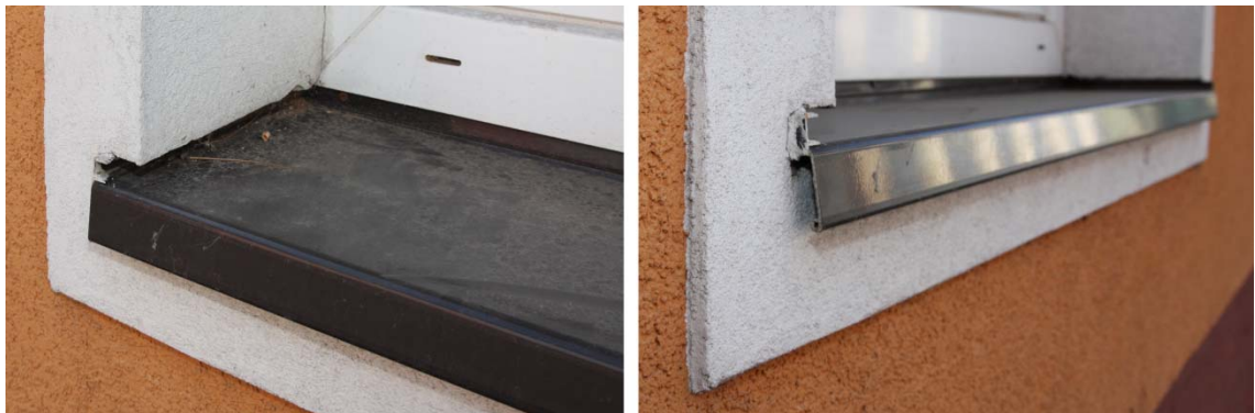
Abbildung 97: Beispiel für zu geringen Überstand der Abtropfkante
