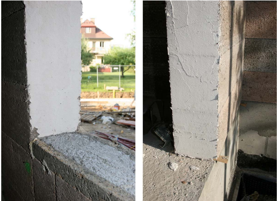
Abbildung 69: Glattstrich an Leibungsfläche
