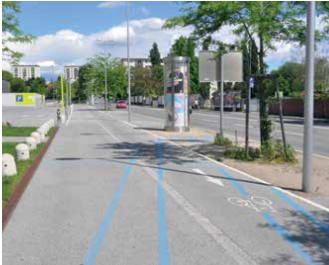
Abb. 6.81 Bestehender Radweg Fröhlichgasse
