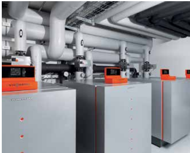
Abb. 6.182 Wärmepumpen in Kaskade
