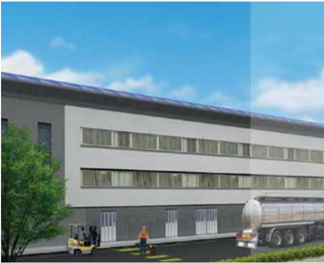
Abb. 6.209 Windrail auf Flachdach montiert 1
