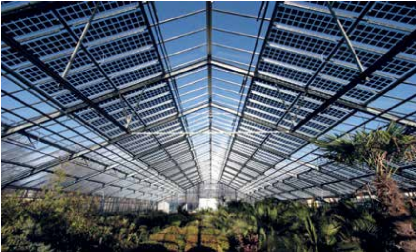
Abb. 6.111 Photovoltaikanlage eines Gewächshauses
