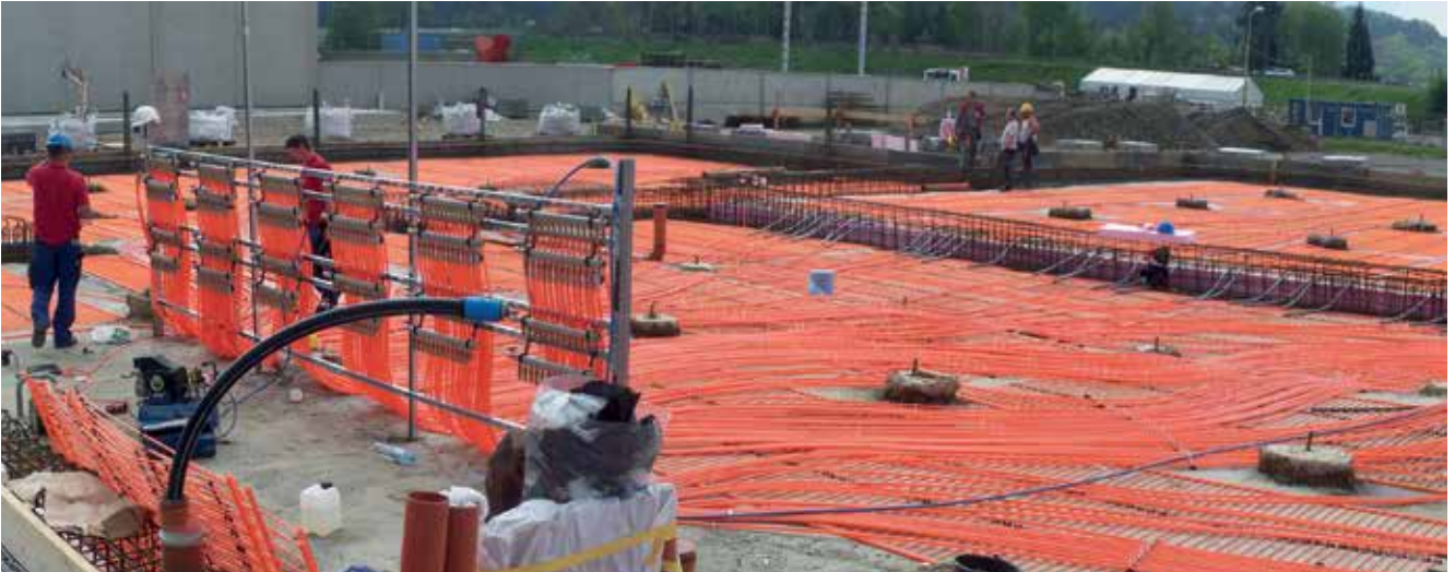
Abb. 6.178 Erdspeicher (System www.bes-eu.com)
