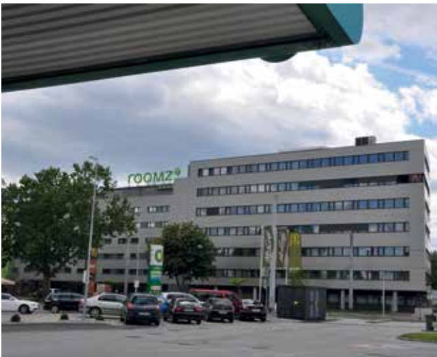
Abb. 2.9 Verwaltungs- und Hotelgebäude
