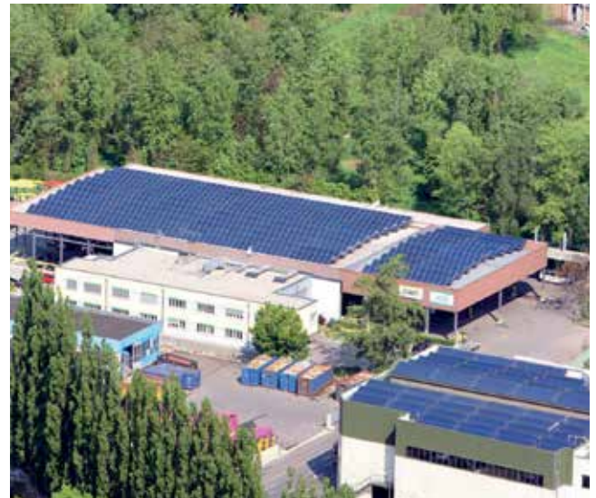
Abb. 5.3 Solaranlage Abfallwirtschaft Holding Graz
