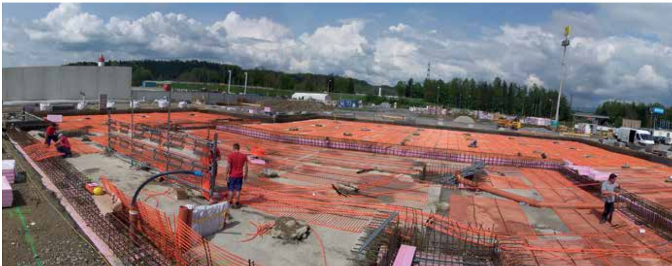
Abb. 6.177 Erdspeicher (System www.bes-eu.com )
