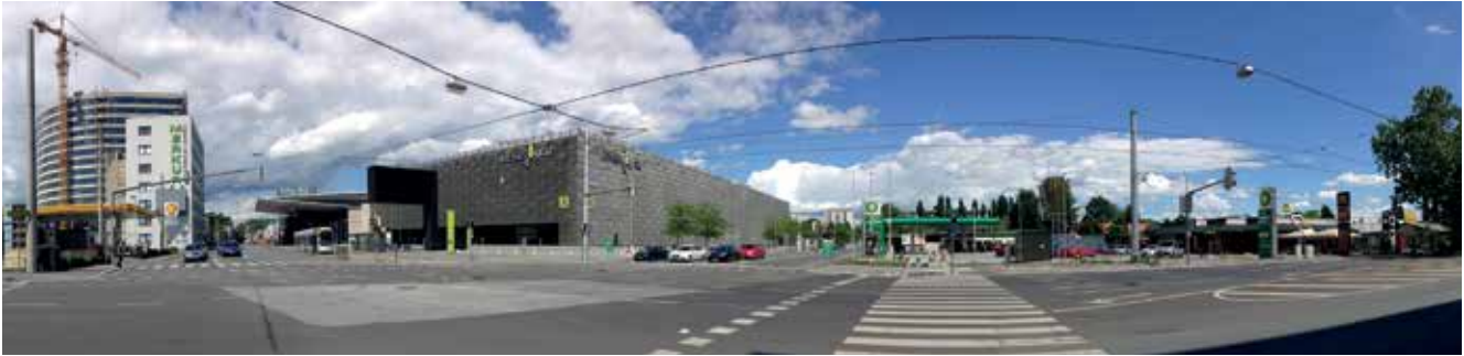
Abb. 3.13 Kreuzung C.v.Hötzendorf-Straße / Fröhlichgasse, Blick Richtung Grazer Messe
