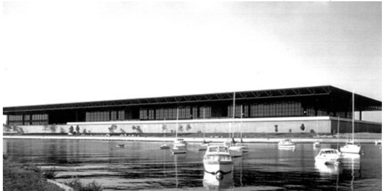
Abb. 60 Lakeside Center Ostansicht, vom Northerly Island aus gesehen, 1970
