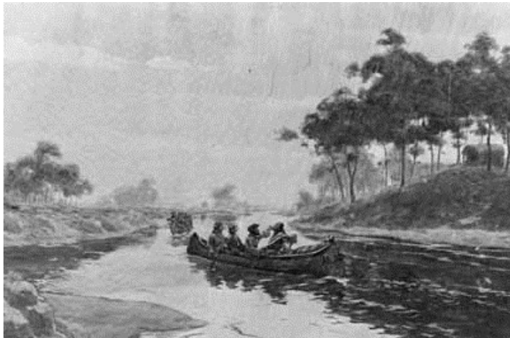
Abb. 11 1673, die Erkundung des neu entdeckten Landes durch Joliet and Marquette
