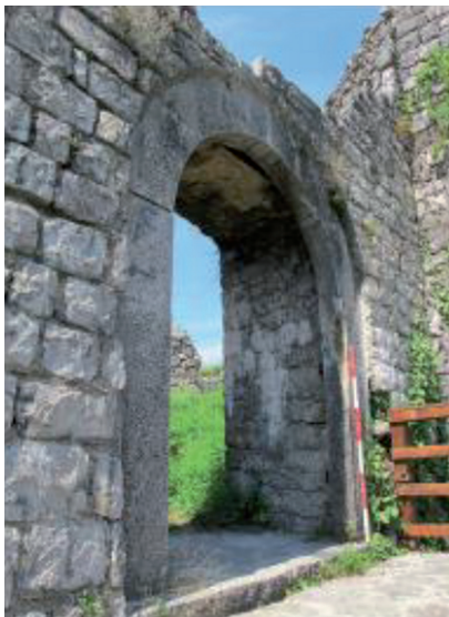
Abb. 61: Eingangstür von Außen
