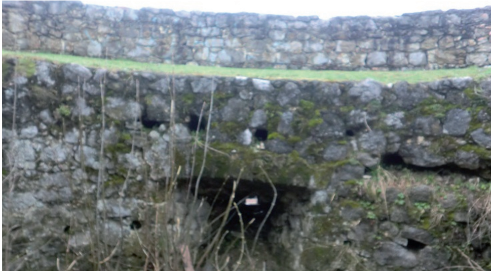
Abb. 66: Die Öffnungen mit dem Zwischenpodest
