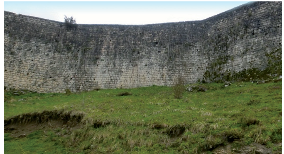
Abb. 59: Westlicher Teil der Stadtmauer
