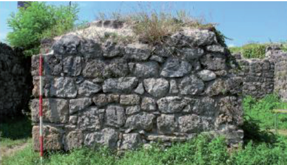
Abb. 73: Ein Pfeiler im Raum L
