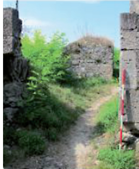
Abb. 79: Verbindungstür in den Raum N
