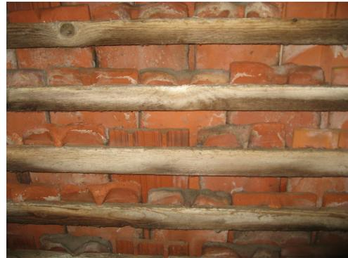
Abb.35,36: Sparrendach und Deckung von Innen
