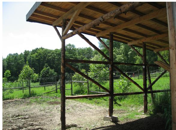
Abb.91a,b: Fressstand (li.) und Gruppenunterstand ohne Verkleidung (re.)
