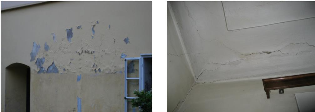
Abb.33,34: Wand Innenhof EG Mauerwerksaufblühungen (li.) und Risse im 1.OG in der Decke (re.)
