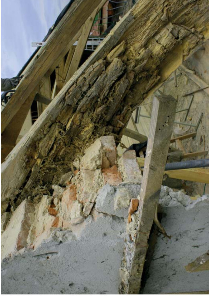
Abb. 115 links: Morsche Tragstruktur / rotten static structure
