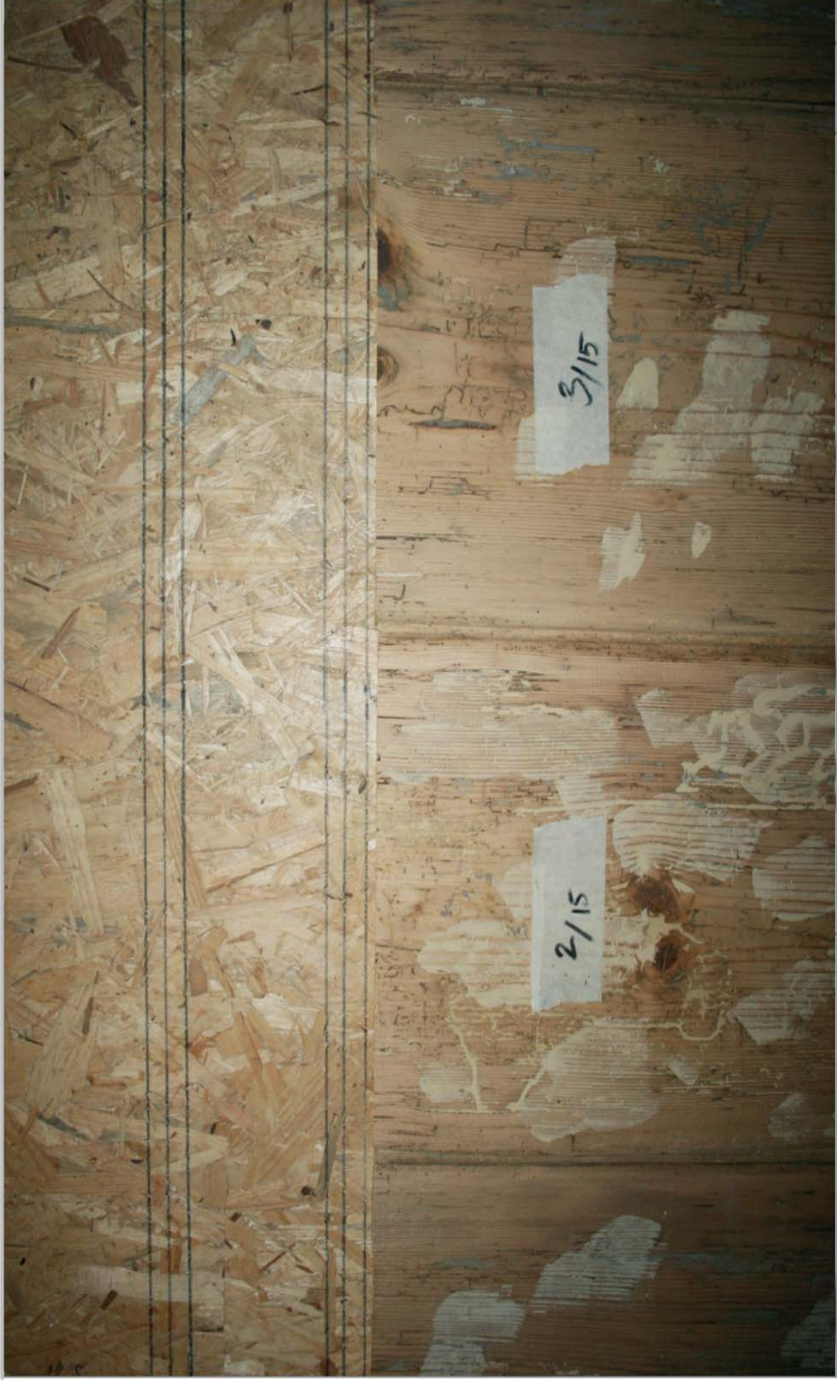
Abb. 099: Altholzboden Zuschnitt / pre-cut wooden floor
