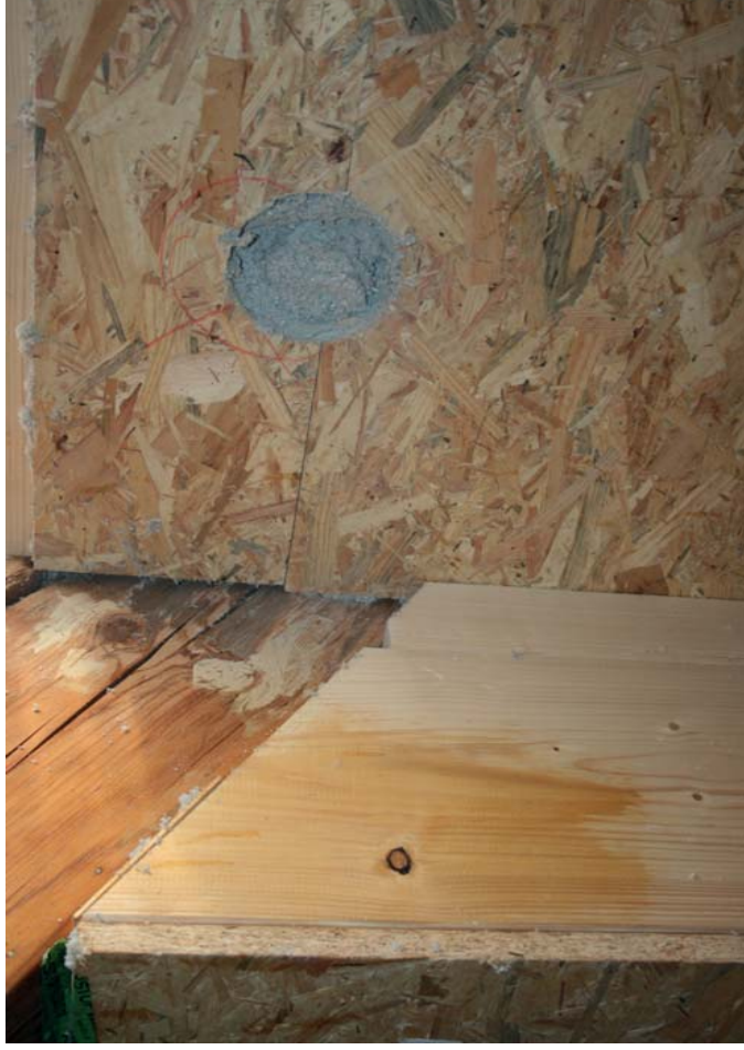
Abb. 145 links: Ausblasen der Wände / compressed insulation Abb. 146 rechts: Aufbau Aussenwände / construction exterior walls
