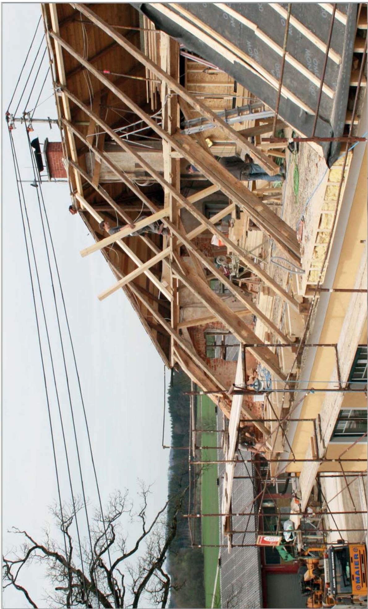
Abb. 111: Dacharbeiten / roof works
