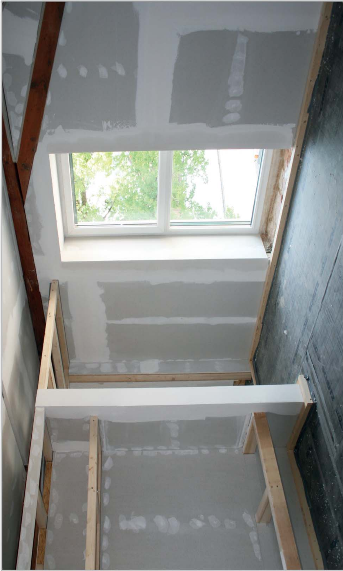
Abb. 150: Rigipsarbeiten / gypsum plaster board works
