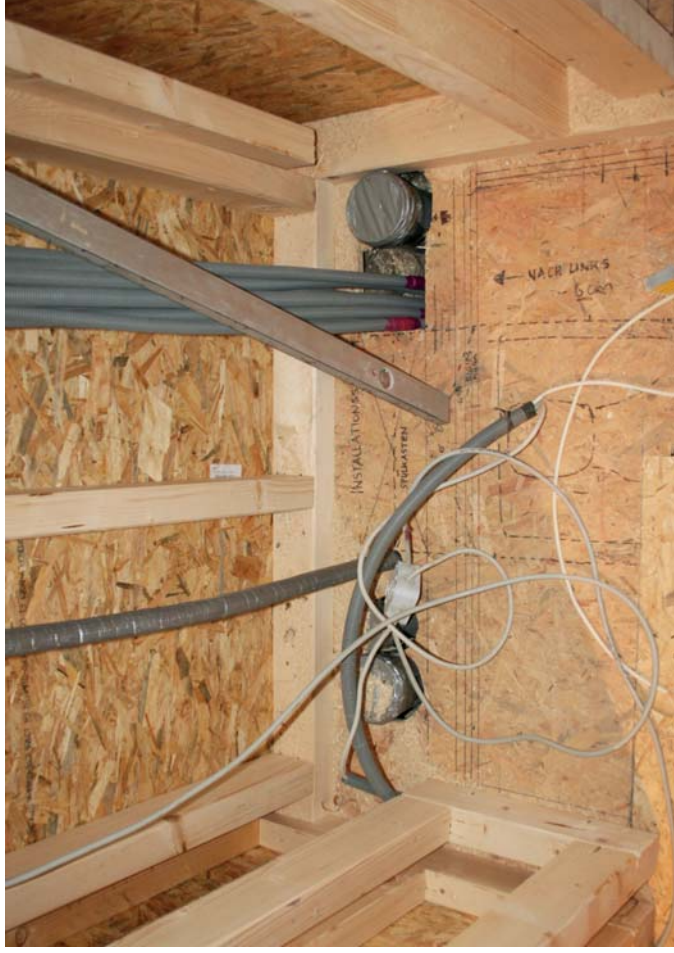
Abb. 100 links: Leitungsweiterführung / continuation of the pipes Abb. 101 rechts: Konstruktion Decke / construction of the ceiling
