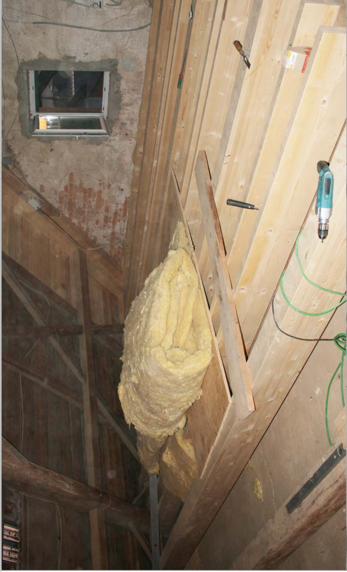
Abb. 096 : Verstärkung des Bodens / fortification of the floor
