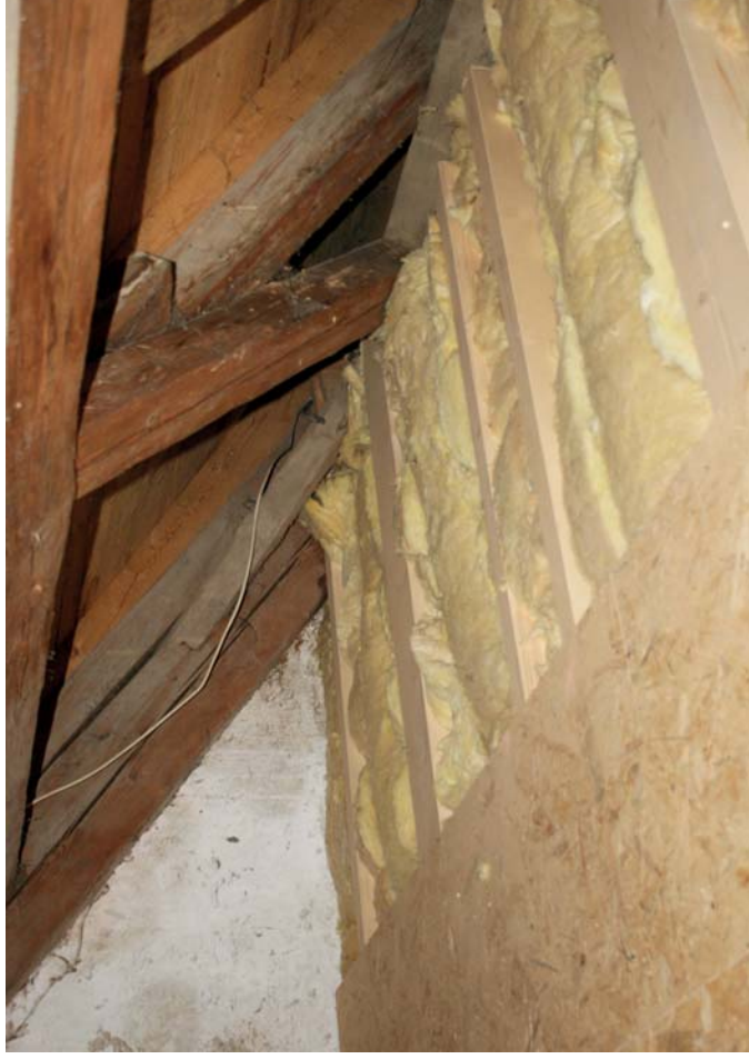
Abb. 097 links: Dämmarbeiten / insulation work Abb. 098 rechts: Trägerplatte OSB / mounting plate wood chips
