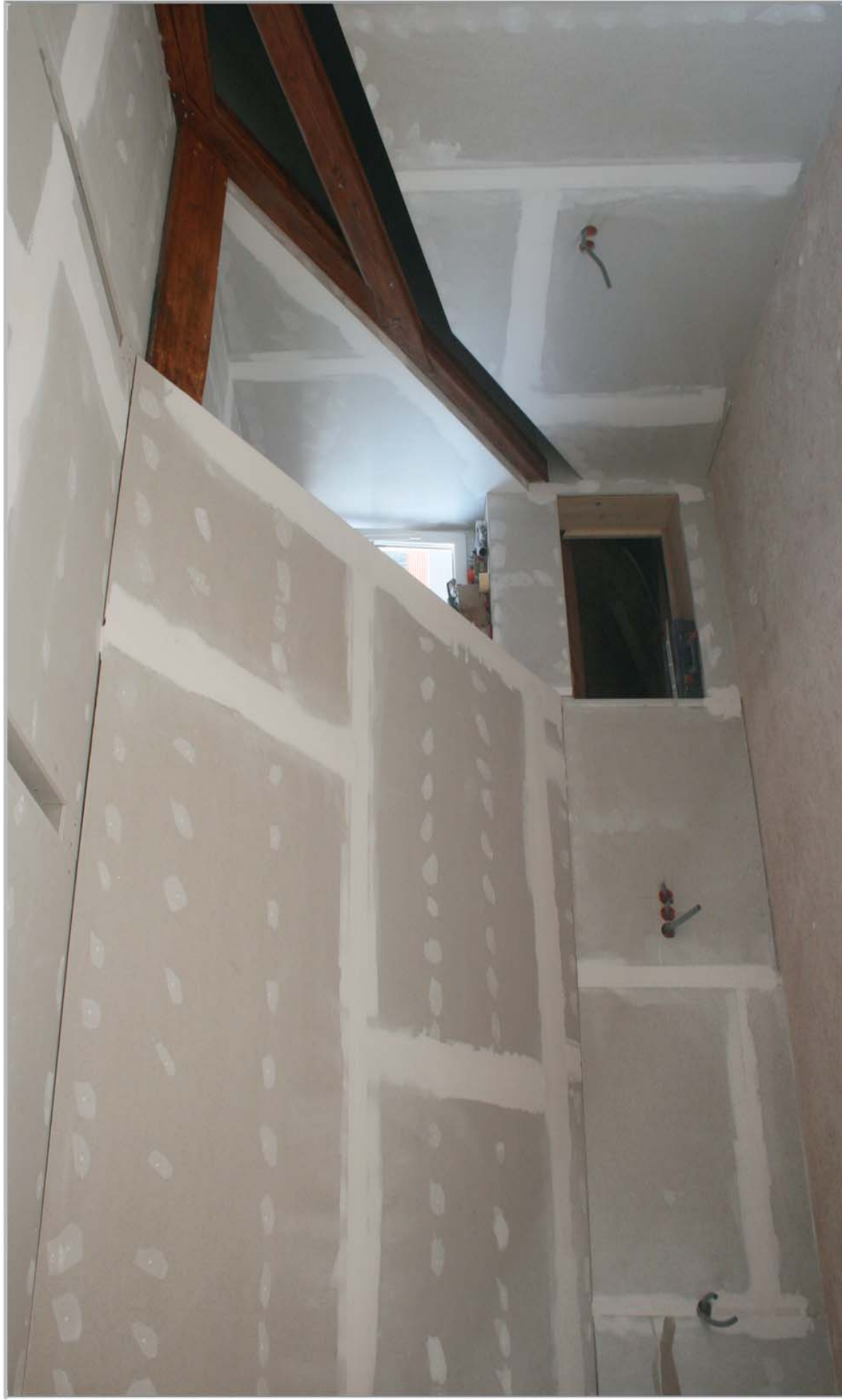
Abb. 149: Rigipsarbeiten / gypsum plaster board works
