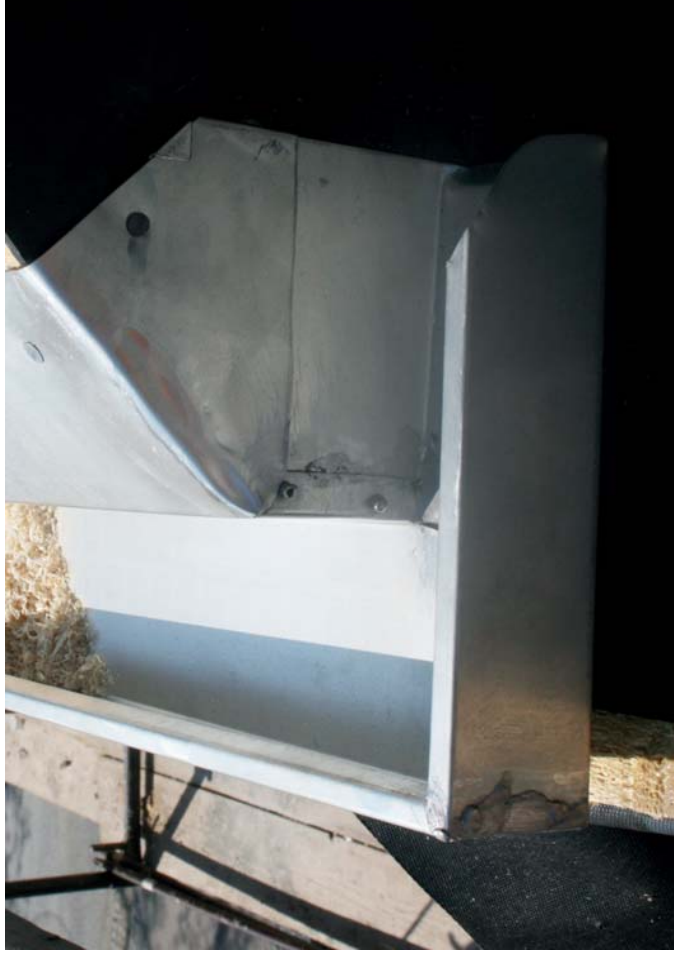
Abb. 127 links: Spenglerarbeiten / tinsmith works
