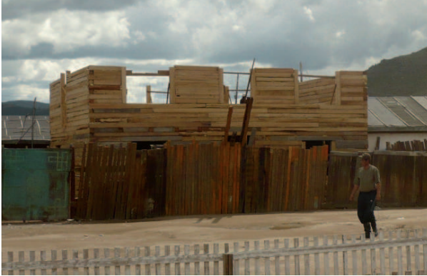
Phase-2: Holzblockhaus ohne Dämmung
