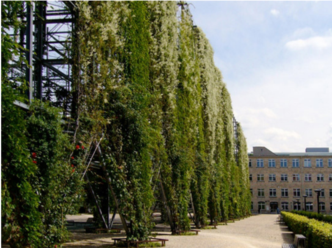
Abb.27 Außenansicht des MFO - Park
