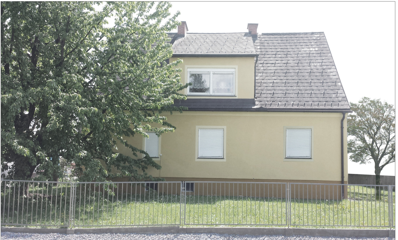
Abb.35 BESTAND Einfamilienhaus Petersbachstraße
