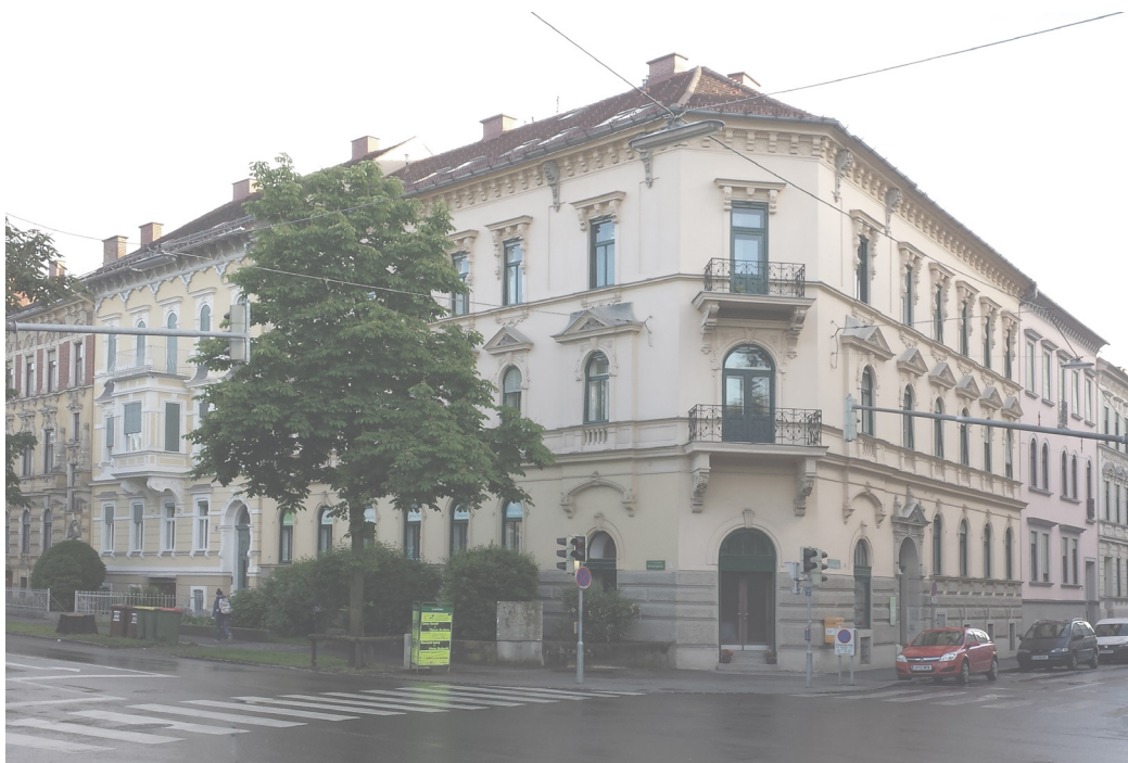
Abb.37 Wohngebäude Merangasse / Nibelungengasse
