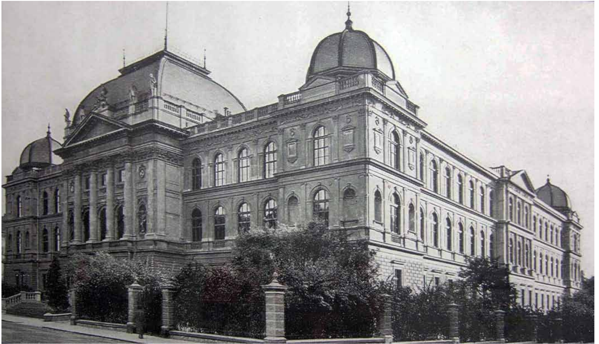
Bild 47: Historische Fotografie vom Gebäude der „Alten Technik“
