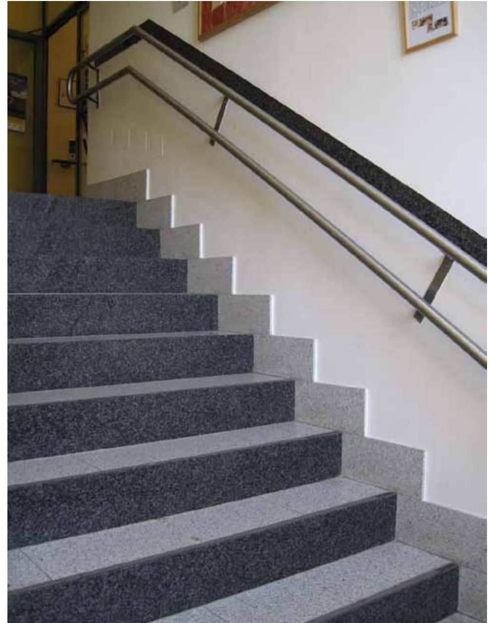
Bild 38: Kontrast zwischen Tritt und Setzstufen, Handlauf gut kontrastierend und zweiläufig
