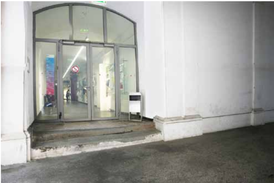
Bild 57: Derzeitiger Zustand des Eingangs zum Dekanat mit verwitterten Stufen und schwer zu öffnender, schlecht wärmegeämmter Glastüre
