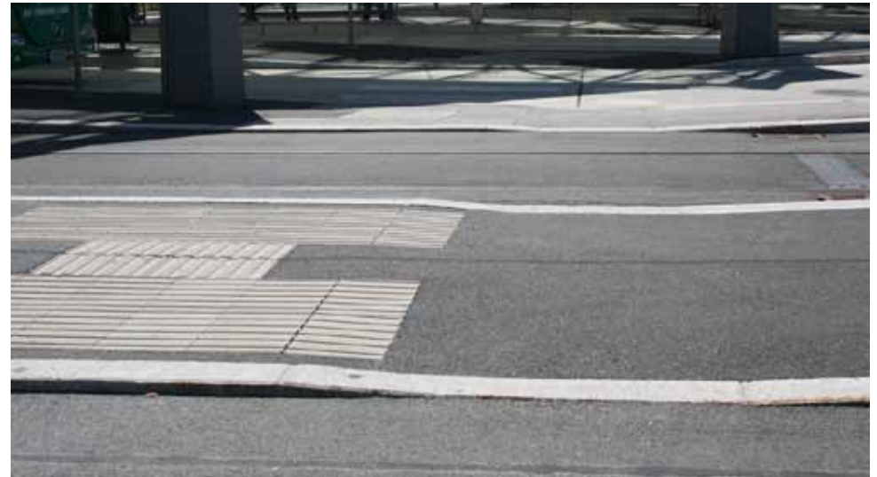
Bild 17: Verkehrsnotenpunkt Puntigam, Umsetzung des „Grazer T“ mit Aufmerksamkeitsfeld, Bodenleitstreifen und Nullabsenkung
