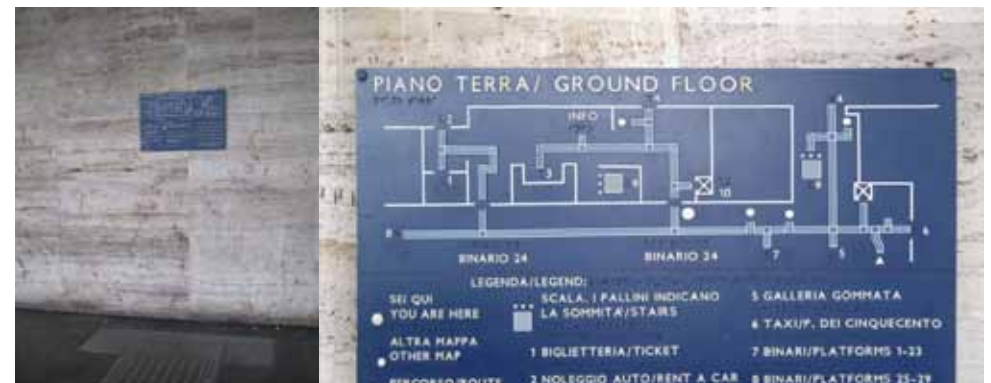
Bild 37: Taktile Plan vom Bahnhof in Rom mit einem taktilen Bodenleitsystem und Brailleschrift
