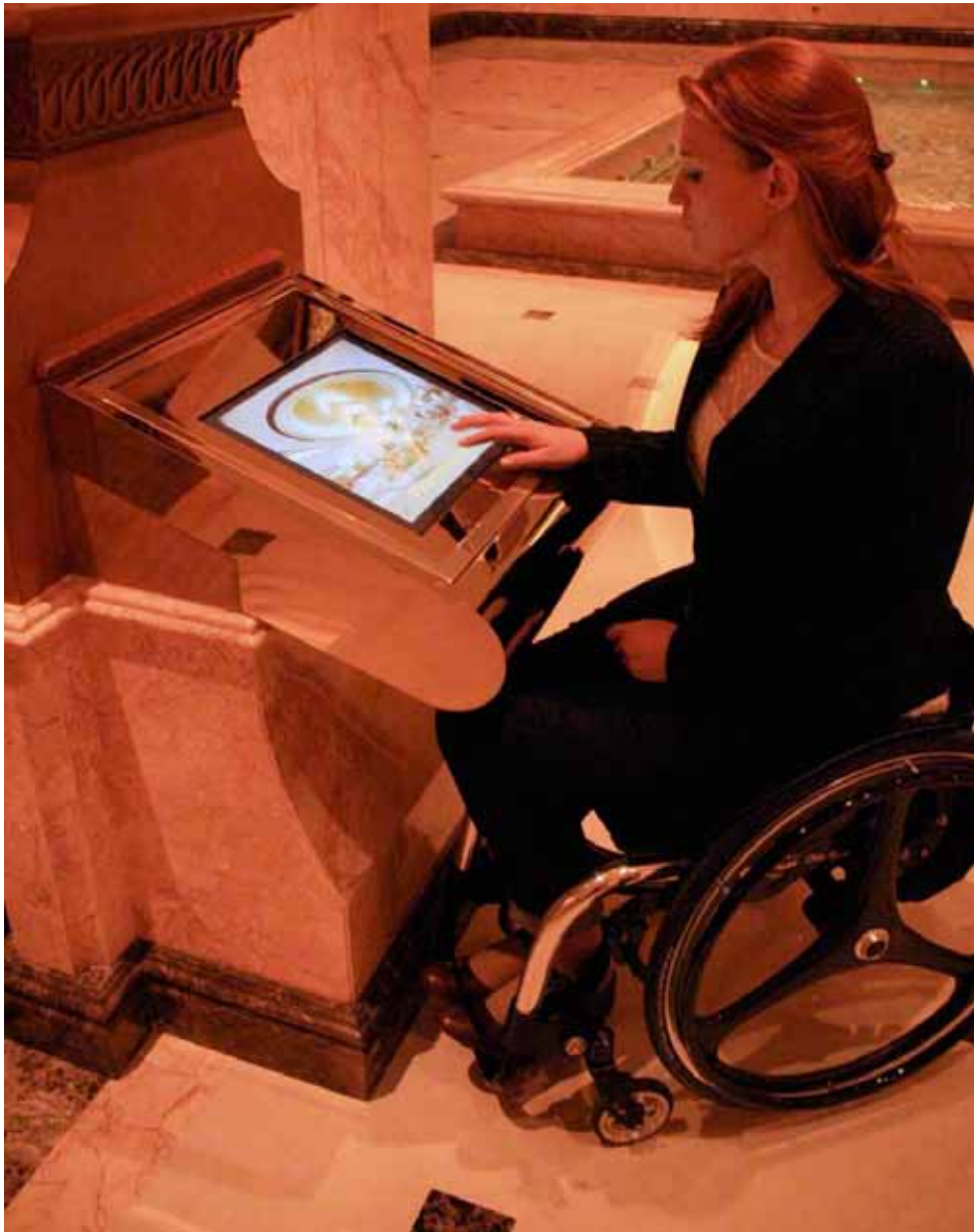
Bild 32: Unterfahrbarer, tiefer gesetzter Infoscreen in einem Hotel, Abu Dhabi
