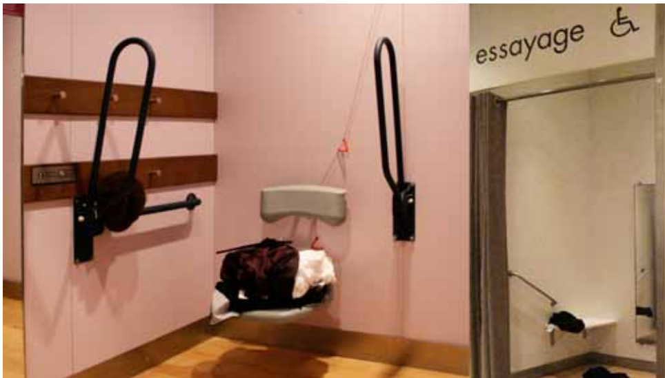
Bild 28: Barrierefreie Anprobekabine in London und Lyon mit Sitzgelegenheit, Haltegriffen, niedrigen Kleiderhaken, Spiegel und Notruf
