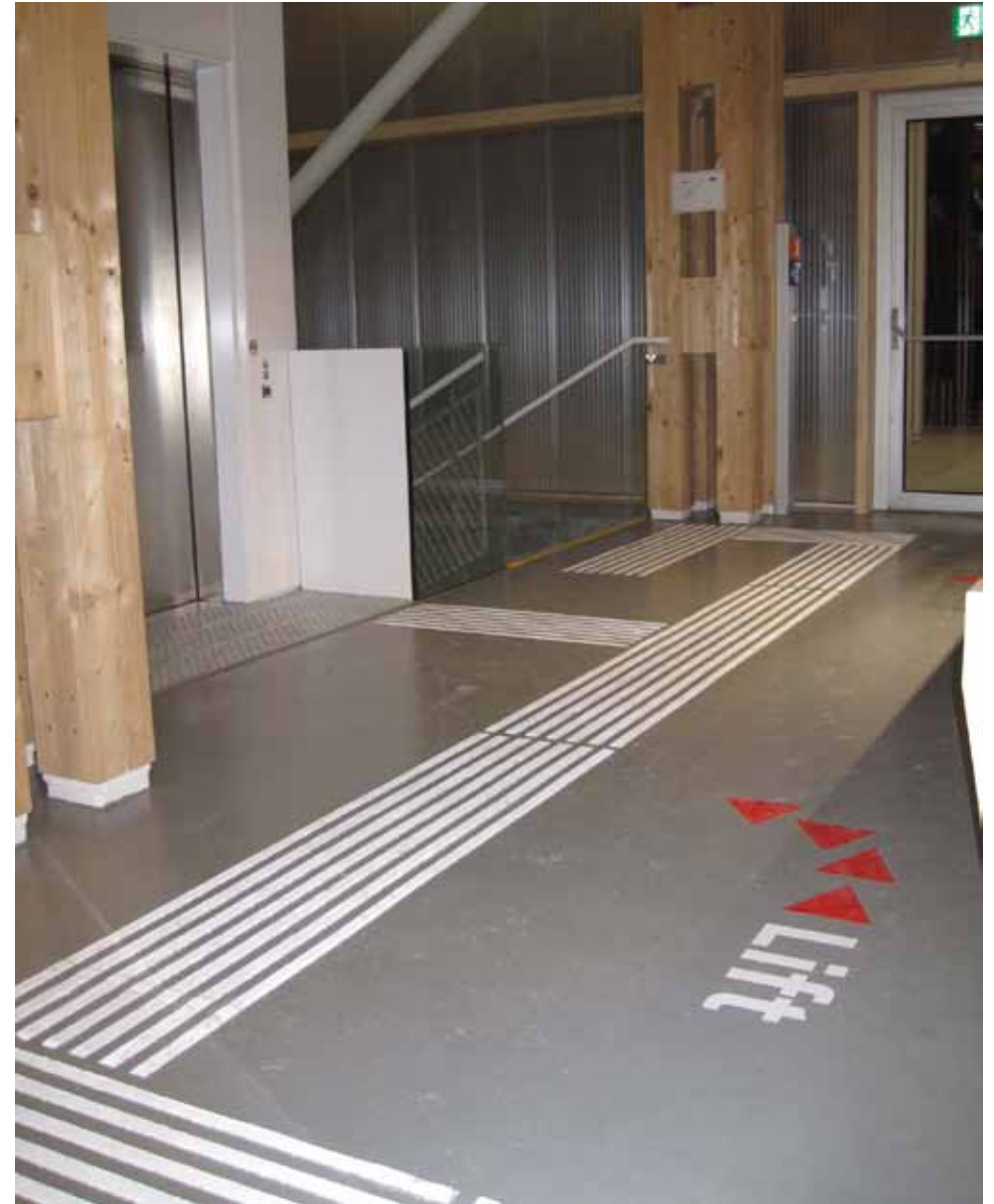
Bild 78: taktile Bodenleitstreifen aus Kunstharz mit einem Aufmerksamkeitsfeld vor abwärtsführender Treppe, ÖBB
