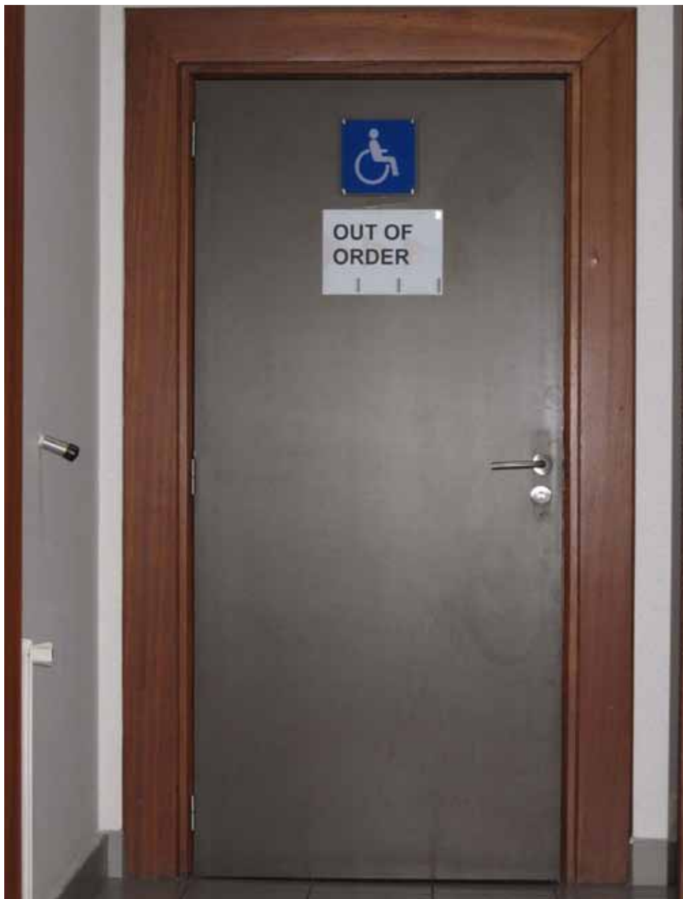
Bild 45: Ein Bild, dass sich in Europa nicht mehr all zu oft wiederholen sollte: der barrierefreie WC Raum ist nicht in Betrieb und einen Ersatz dafür gibt es nicht.
