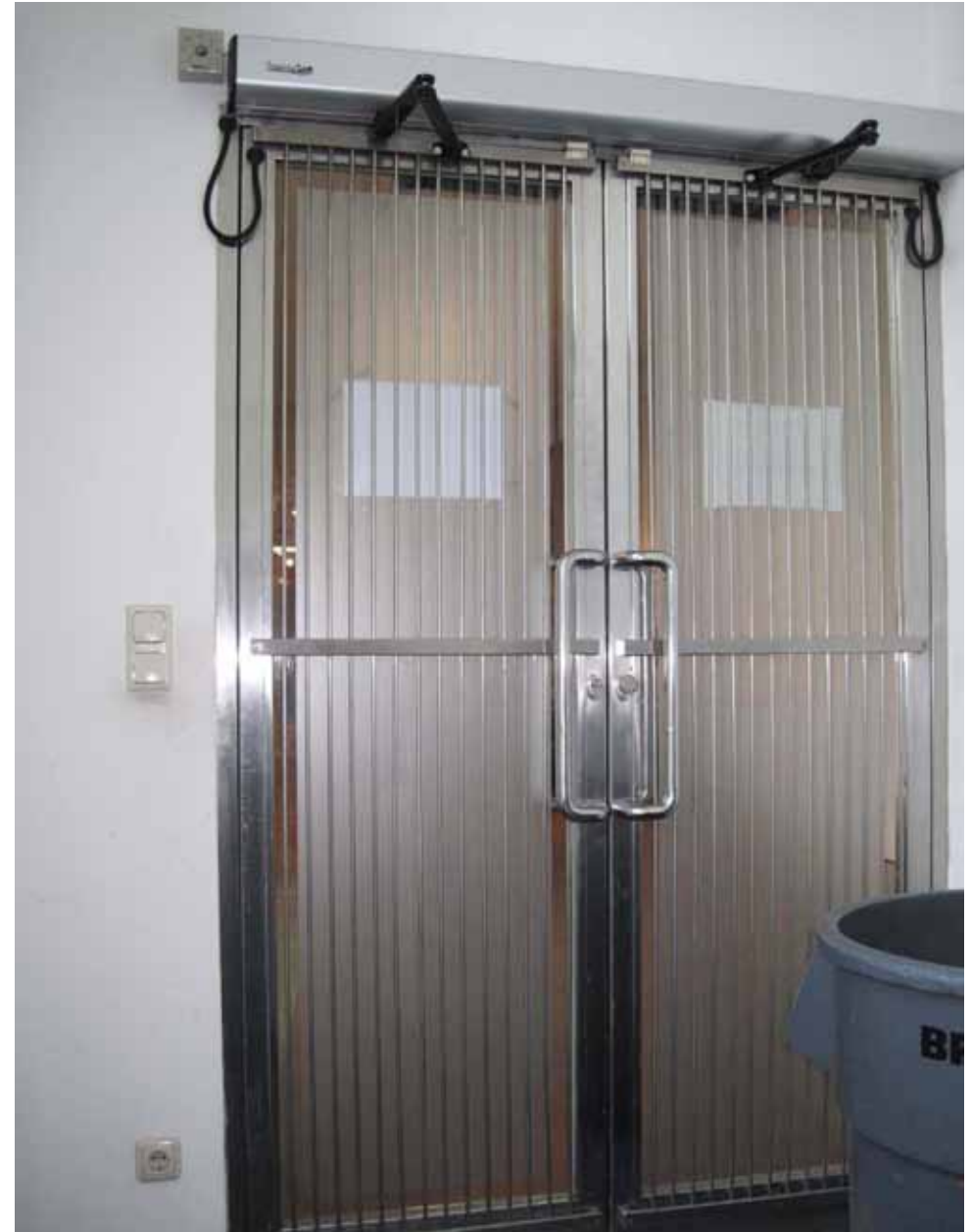
Bild 39: Mit Türöffnungsautomatik nachgerüstete, historische Türe beim Radiokulturhaus in Wien
