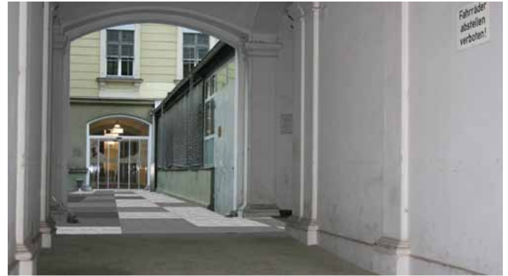
Bild 60: Blick in von der neu errichteten Rampe in den ersten Hof mit Belag
