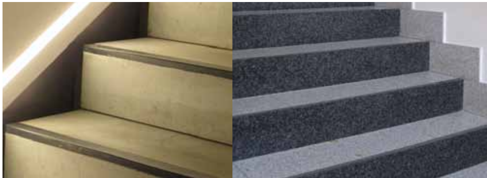
Bild 86: LINKS: kontrastreiche und rutschfeste Gummibänder sind in der Fertigteiltreppe als Stufenmarkierung schon beim Produktionsprozess miteingebaut RECHTS: Verschiedenfarbige Oberflächen von Setz- und Trittstufe statt einer Stufenmarkierung.
