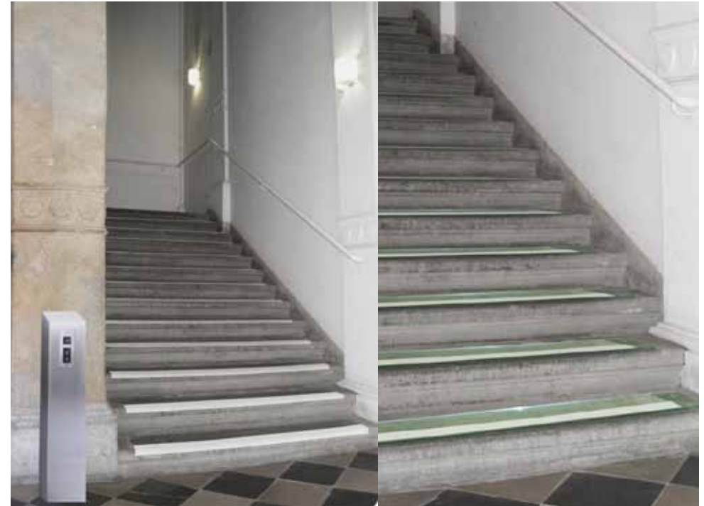
Bild 87: LINKS: Treppe und Stufenmarkierungen lt. ÖNORM B 1600 i.d.g.F. - RECHTS: Variation der Stufenmarkierung - VSG mit gefärbter Unterseite
