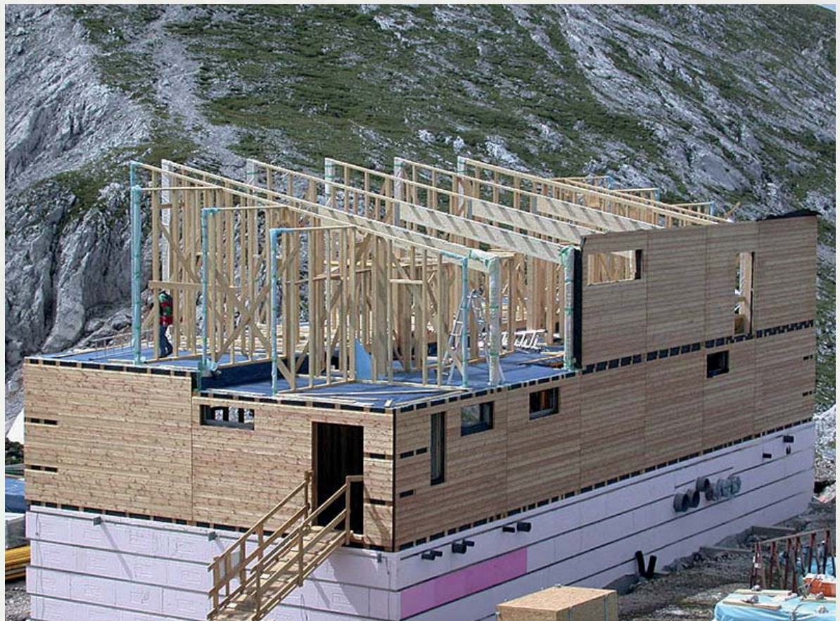
Schiestlhaus im Bau
