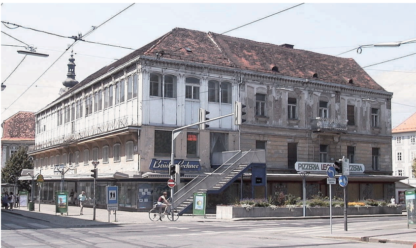
Abbildung 28: Eiserne Haus vor dem Umbau 2003
