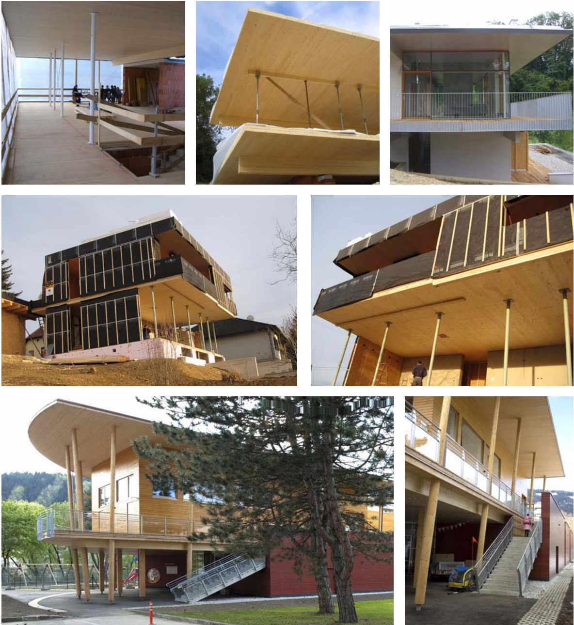
Abb. 1.3 Ausführungsbeispiele von punktgestützten Brettsperrholzplatten (vgl. [4], Kap. B)
