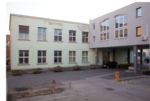
> Abb. 26 Fassade - Nord
