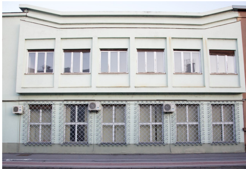
> Abb. 28 Erweiterung der Verwaltung - Verbindung der Gesimse
