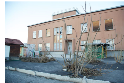
> Abb. 25 Fassade - Süd
