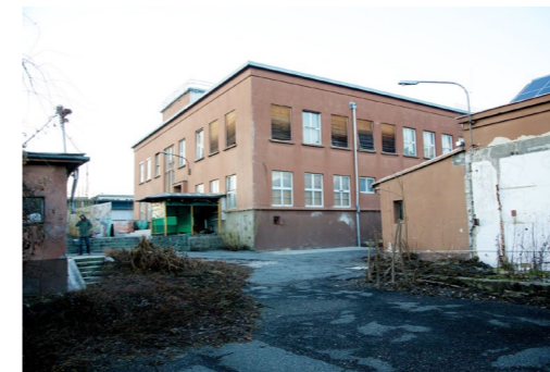
> Abb. 24 Fassade - Ost
