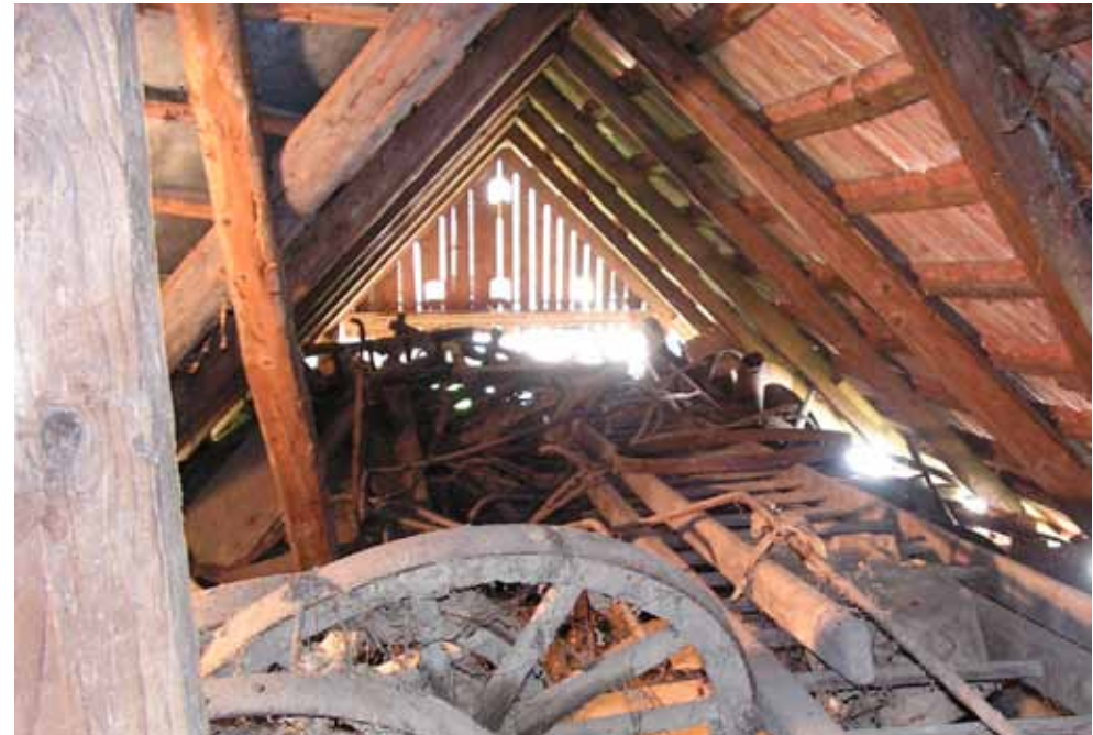
Abb.61 Dachstuhl des Eiskellers
