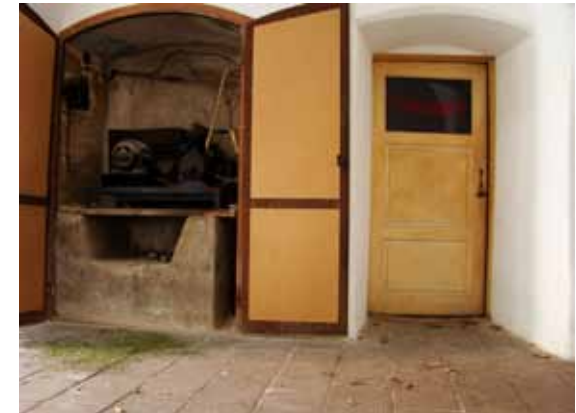
Abb.55 Eingang zur ehemaligen Fleischerei, links im Bild das Kühlaggregat für den Kühlraum
