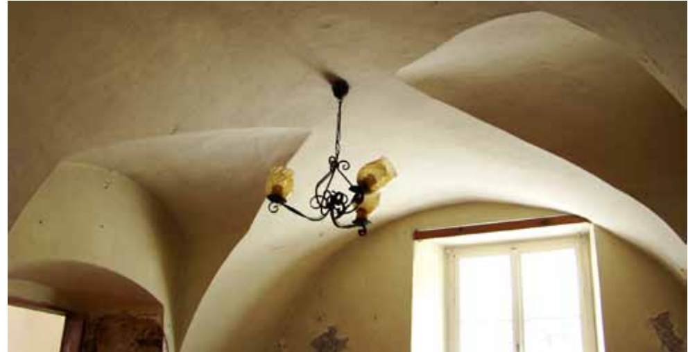
Abb.48 Kreuzgewölbe in der Stube im Erdgeschoß
