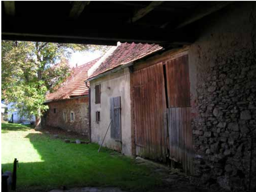
Abb.65 Rückseite des Wirtschaftsgebäudes
