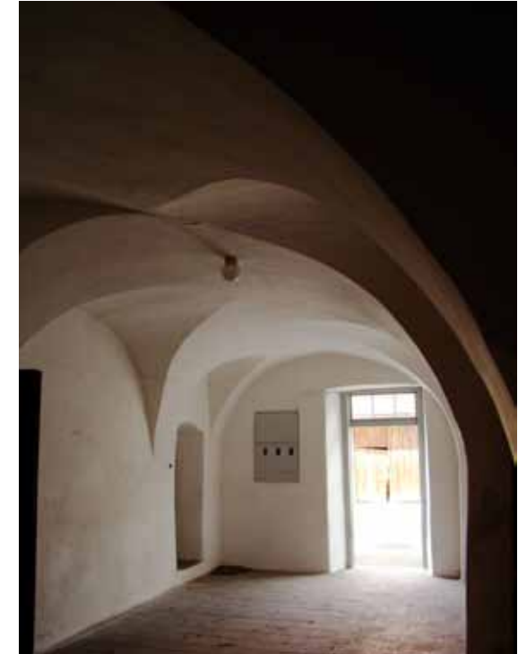
Abb.43 Kreuzgewölbe im Erdgeschoß des Bürgerhauses
