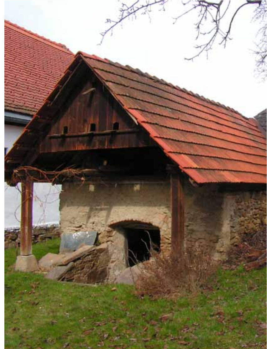
Abb.58 Eingangsbereich des Eiskellers
