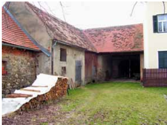
Abb.66 Rückseite des Wirtschaftsgebäudes
