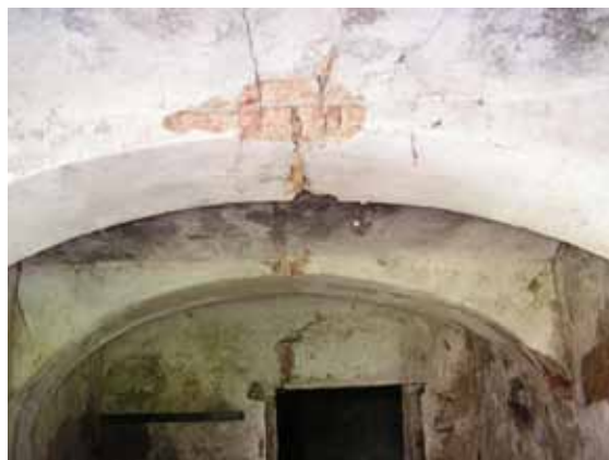
Abb.60 Gewölbe vor der Sanierung
