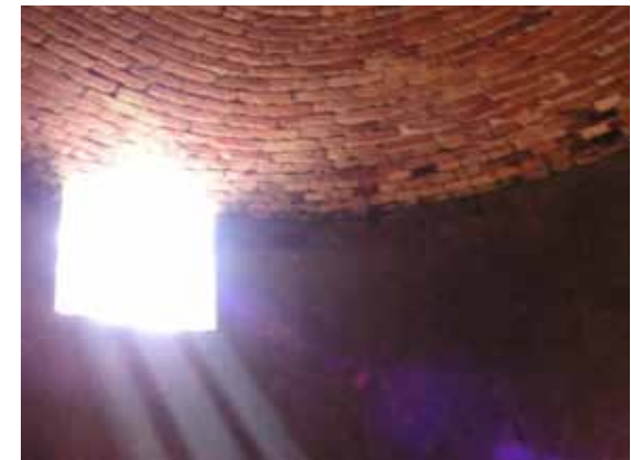
Abb.62 Gewölbe im "Turm" des Eiskellers
